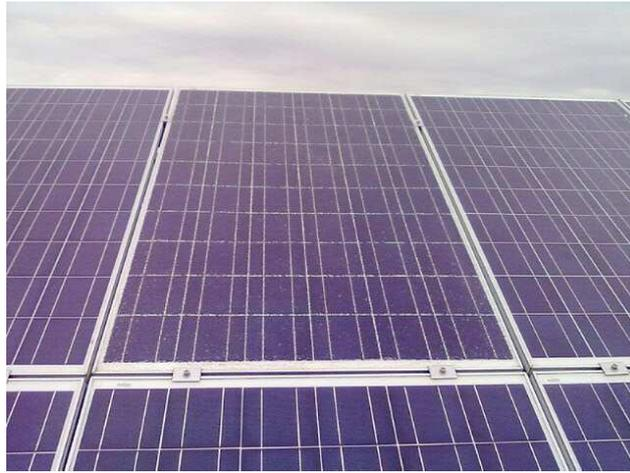
Fig.3.28-Modulo con superficie compromessa
