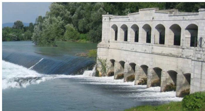
Figura 11.3.3.1 - Foto delle opere esistenti.
