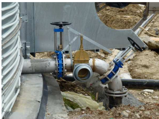
Figura 10.7 - Ghigliottina per l'asportazione dell'accumulo solido.
