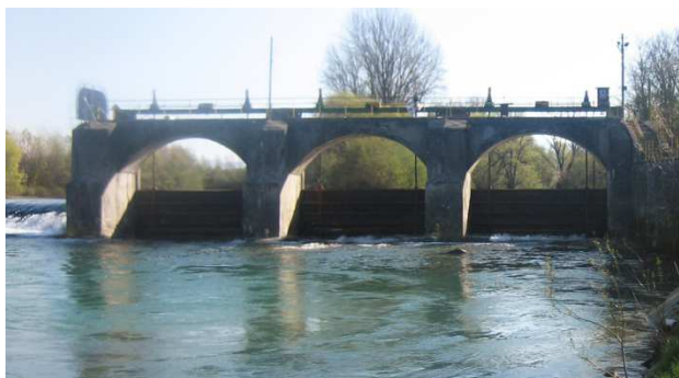
Figura 11.3.2.2 - Foto delle opere esistenti.
