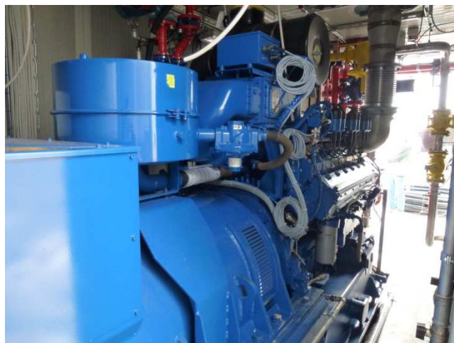
Figura 10.15 - Motore-generatore.
