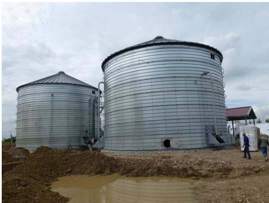
Figura 10.4 - Digestori anaerobici.
