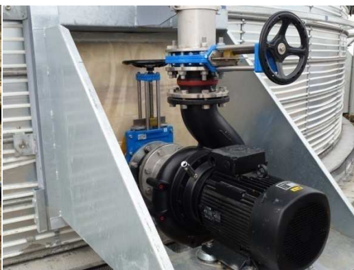
Figura 10.8 - Uno dei motori del sistema di miscelazione.
