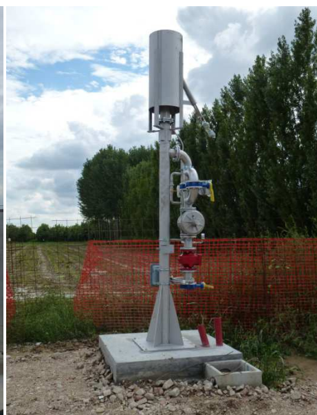
Figura 10.17 - Torcia per il gas in eccesso.
