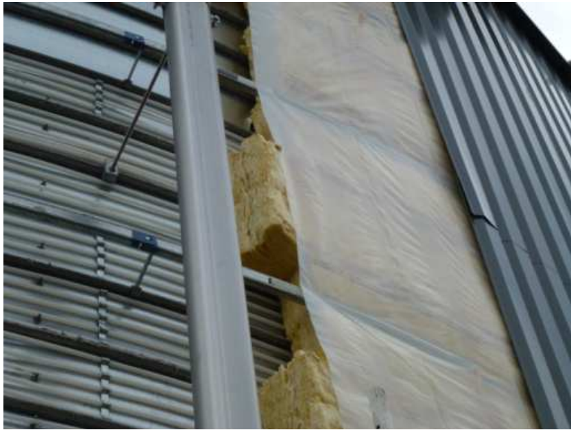
Figura 10.12 - Sistema di coibentazione.
