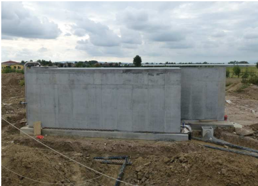
Figura 10.13 - Vasca di scarico digestato.
