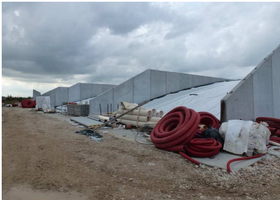
Figura 10.1 - Trincee di stoccaggio delle biomasse vegetali.
