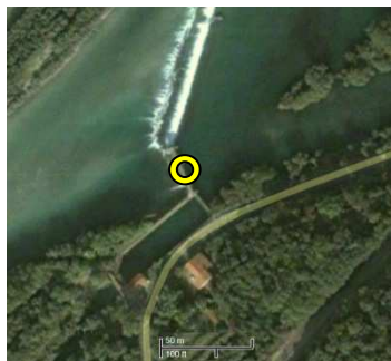
Figura 11.3.2.1 - Veduta aerea delle opere esistenti.
