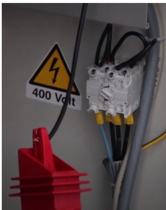
Figura 5.9: Conduttori di fase e neutro interconnessi tra loro
