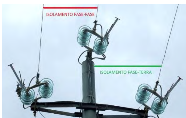
Fig. 2.8 isolamento esterno in aria libera
