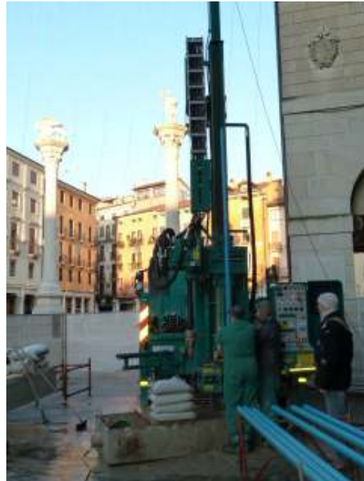
Figura 41 e 42: Inserimento dei tubi in PVC
