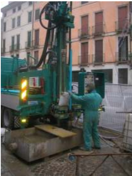
Figura 41 e 42: Inserimento dei tubi in PVC
