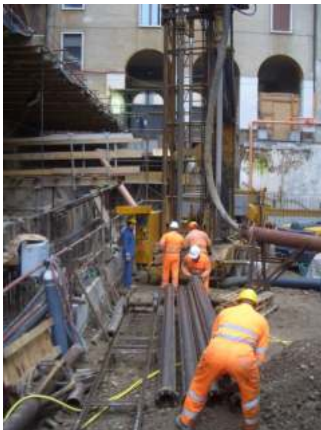
Figura 51: Realizzazione del pozzo PE in Corte dei Bissari
