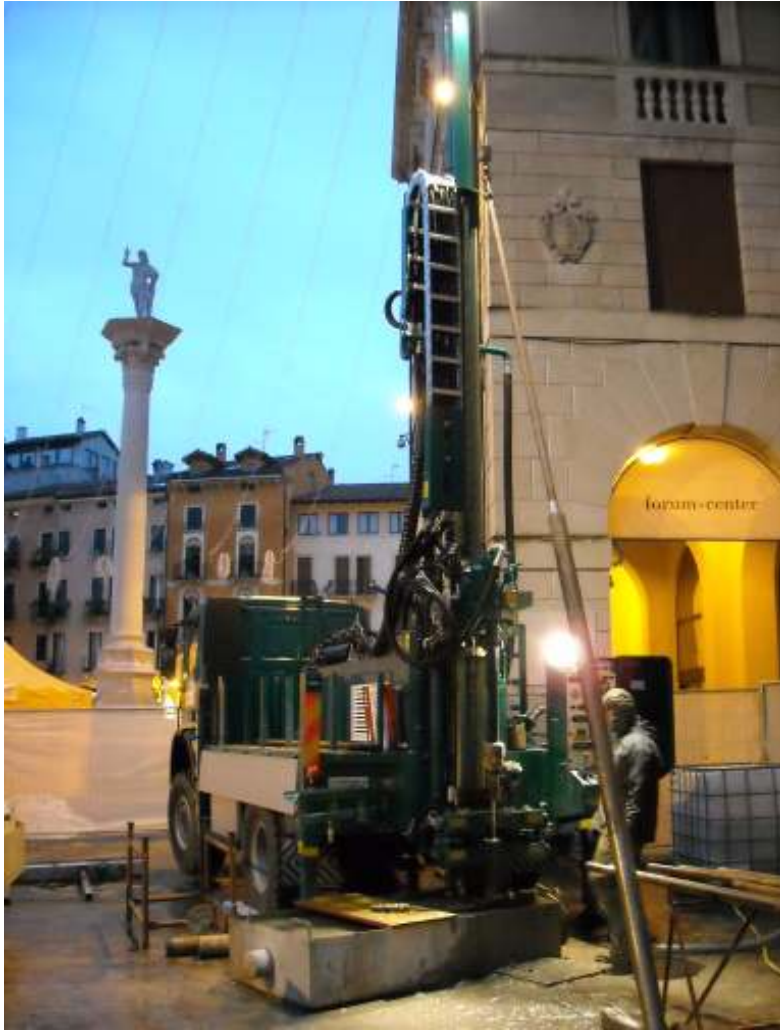
Figura 37: Esecuzione dei sondaggi in Piazza dei Signori
