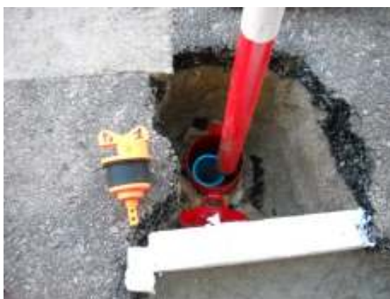
Figura 45: Particolare su Pz1
