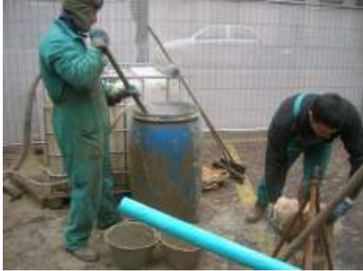
Figura 39: Preparazione della miscela bentonitica
