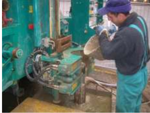
Figura 40: Aggiunta della miscela bentonitica
