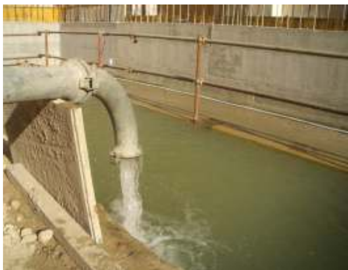
Figura 54: Scarico superficiale dell'acqua di falda
