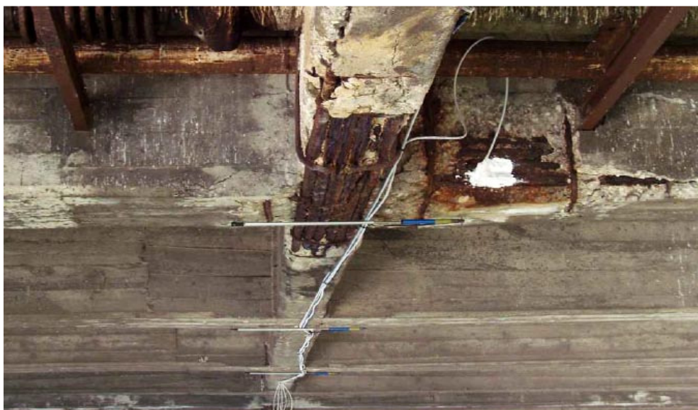
Fig. 53 – Posizionamento dei trasduttori di deformazione.
