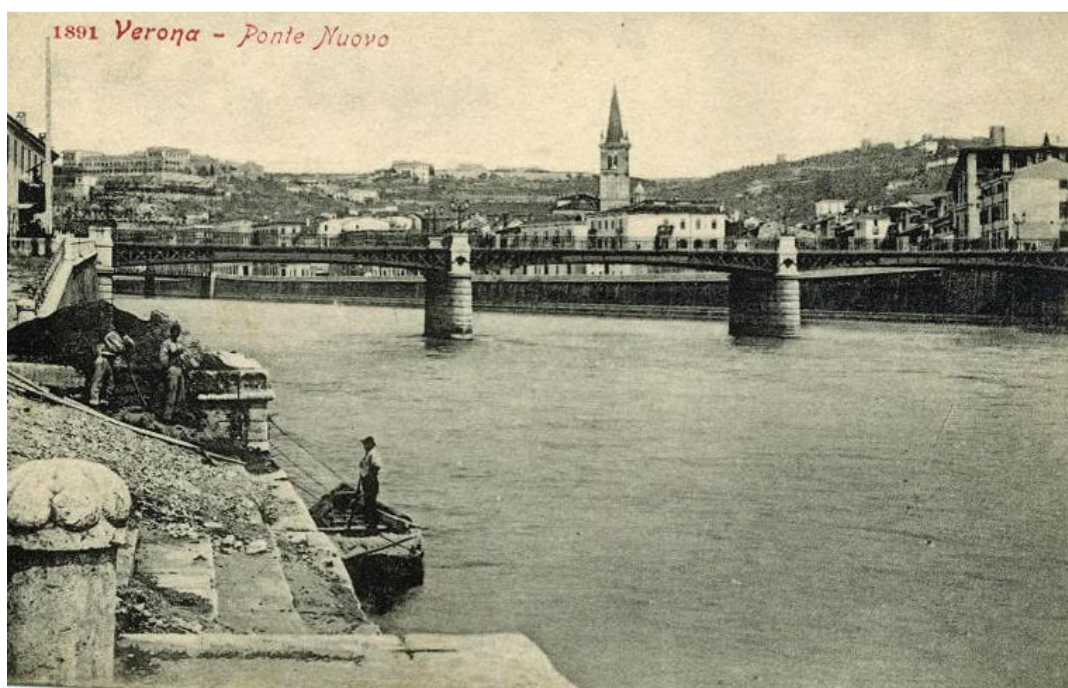
Fig. 51 – Il Ponte Nuovo nel 1891.
