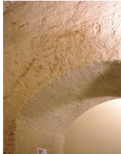
Figura 7.25 – fessurazione a piano terra
