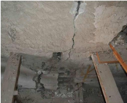
Figura 7.24 – apertura della fessurazione a piano secondo
