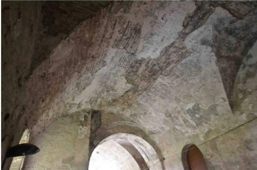
Figura 2.21: Volte lunettate-rivellino
