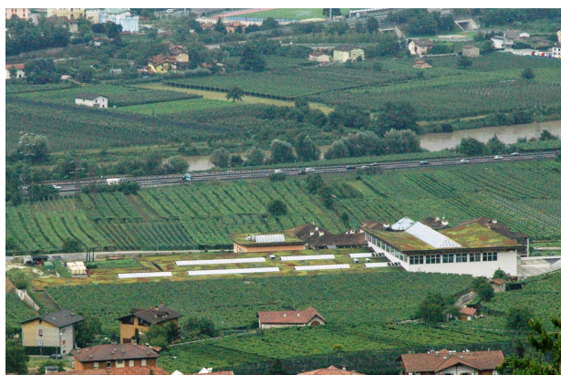
Figura 3.1 e 3.2 Esempio di copertura a verde pensile estensivo sopra lo stabilimento della distilleria ‘Marzadro Grappe’ con sede a Nogaredo in Provincia di Trento. Nella figura a sinistra si può osservare la copertura a verde pensile dall’alto e notare come tale sistema a verde sia ad impatto visivo ridotto rispetto all’ambiente circostante. Nella figura a destra un particolare del verde estensivo utilizzato su tale copertura.
