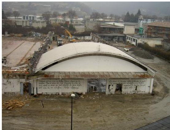
Figura 8.1 Capannoni dello stabilimento ex Cederna in demolizione
