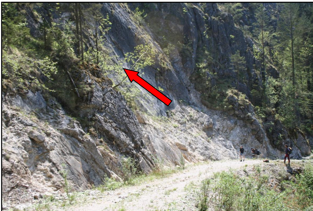
Fig. 6 Affioramento principale e movimento blocco mancante indicato dalla freccia rossa
