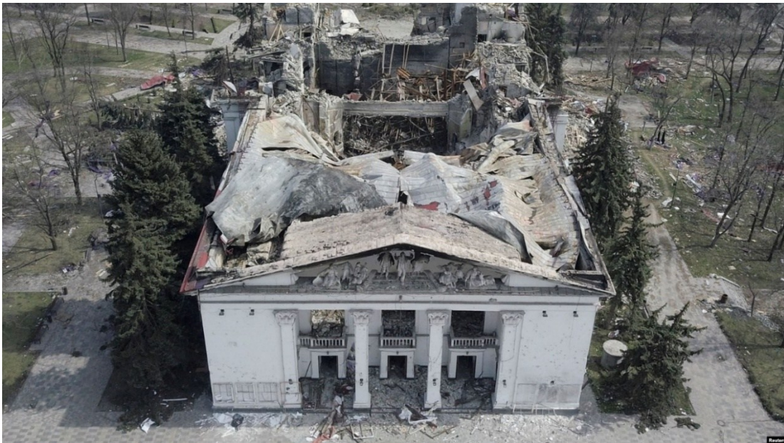
Fig. 24: L'edificio del Teatro Drammatico di Mariupol ridotto in macerie dopo il bombardamento aereo. Fonte: Radio Svoboda (2022).
