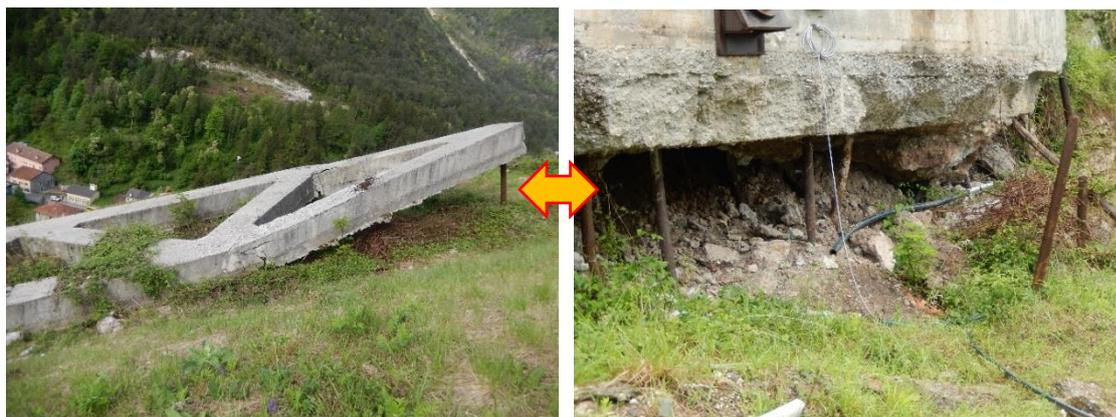
*Figura 35 Esempi di venuta a giorno delle fondamenta. Foto dello scrivente, datate 10/05/2018 quella di sinistra e 29/05/2018 quella di destra.*
