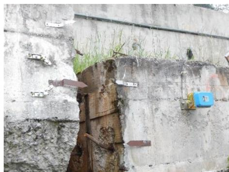
Figura 46 A sinistra disposizione planimetrica dei nuovi estensimetri e fessurimetri installati sul corpo di frana e/o sulle opere antropiche presenti (CLIOS s.r.l. [8]). A destra esempio di fessurimetro a filo installato sul cordolo in cemento del 1992. Foto dello scrivente del 29/05/2018.
