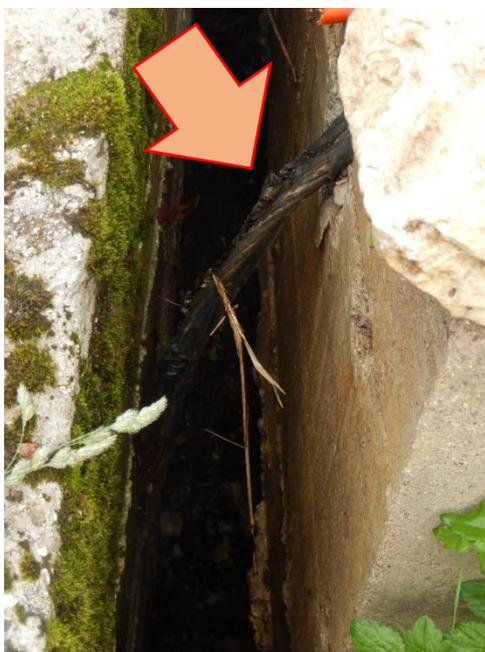
Figura 119 Tirante estremamente deformato e tranciato a tergo del cordolo di cemento del 1992, il quale si è svincolato dalla struttura retrostante probabilmente in occasione dell'evento del 12 dicembre 2017. Foto dello scrivente 29/05/2018.
