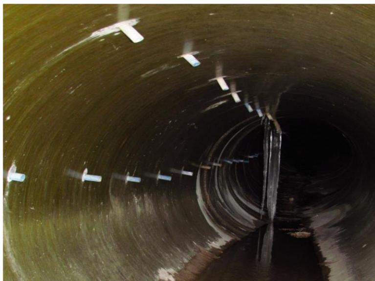
*Figura 76 Immagine della galleria drenante a tergo del muro di sostegno del vecchio tracciato ferroviario, situate a quota 628 m s.l.m.. Foto riportata nella relazione dello Studio Galli “Interventi di mitigazione per gli scenari di rischio geologico, idraulico e di consolidamento dell’abitato di Perarolo di Cadore (BL). STUDIO DI PREFATTIBILITÀ”, (2012) [45].*
