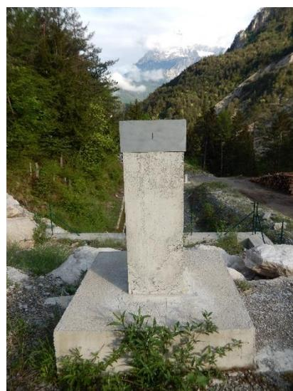
*Figura 161 Pilastro topografico al di sopra della galleria in destra Boite, dove sarà collocato il box contenente la fotocamera da remoto. Foto dello scrivente del 10/05/2018.*
