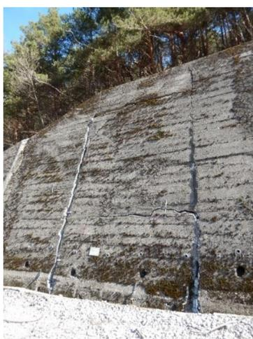
Figura 129 Muro di sostegno a tergo del vecchio tracciato ferroviario intensamente fratturato. Foto dello scrivente del 06/04/2018.
