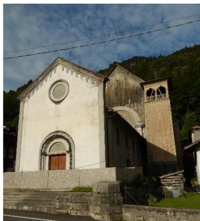
*Figura 49 Chiesa parrocchiale di Perarolo di Cadore, inagibile a causa del fenomeno della subsidenza dovuto alla dissoluzione dei gessi raibliani di substrato. Foto dello scrivente del 10/05/2018.*
