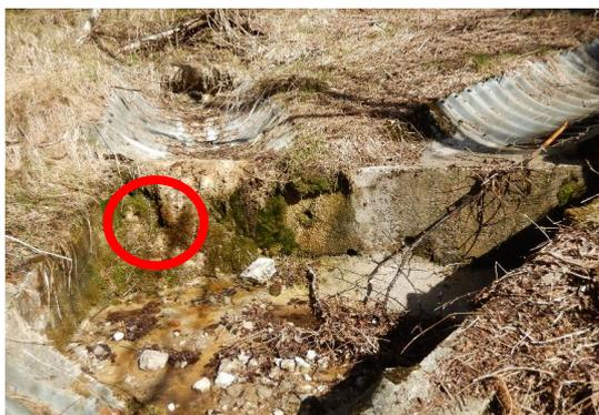
*Figura 91* Nodo in cemento di congiunzione delle canalette drenanti superficiali con rilevamento di emergenze di acqua dal terreno al di sotto di queste – cerchio rosso-. Foto dello scrivente del 06/04/2018.
