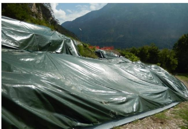
*Figura 173 Impermeabilizzazione della superficie in frana a valle della berlinese con geo-membrane e regimazione delle acque raccolte con la canaletta drenante per opera della Regione del Veneto nell'estate 2018. Foto dello scrivente del 06/09/2018.*
