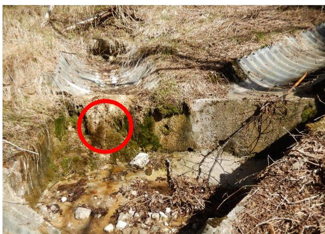
*Figura 10 Nodo in cemento di congiunzione delle canalette drenanti superficiali con rilevamento di emergenze di acqua dal terreno al di sotto di queste – cerchio rosso-. Foto dello scrivente del 06/04/2018.*
