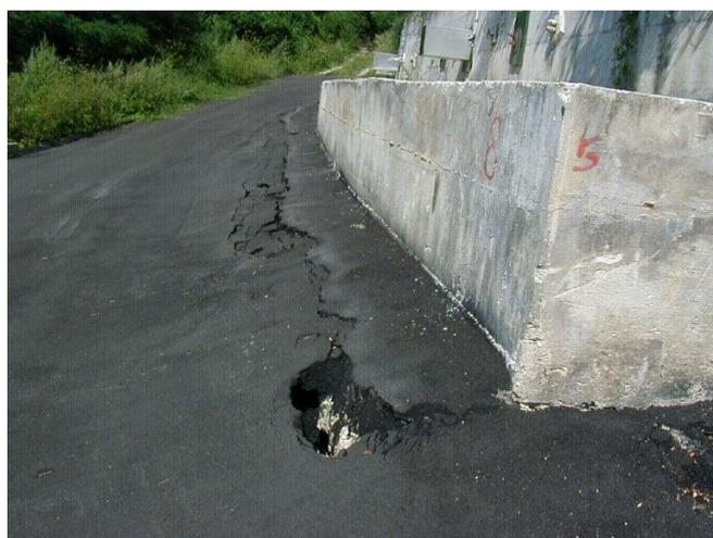
Figura 39 Fessurazione parallela al cordolo tirantato realizzato nel 1992. Foto risalente all'agosto 2000 e riportata nel "Rapporto geologico preliminare sulla frana che ha interessato il centro storico di Perarolo (BL) il giorno 18.11.2000" della Regione del Veneto, Direzione geologia e ciclo dell'acqua (firmata dal Responsabile dell'Ufficio Geotecnico dr. geol. A.Baglioni e dal Dirigente del Servizio Geologia dr. geol. F. Toffoletto), datata 08/01/2001 [41].
