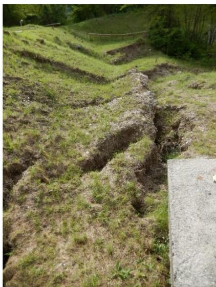
*Figura 34 Fratturazione e sviluppo di contropendenze in prossimità del cordolo rettangolare in calcestruzzo, a monte della scarpata di degradazione principale. Foto dello scrivente del 10/05/2018.*
