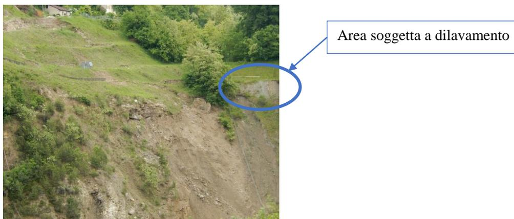
Figura 54 Corpo di frana e porzione sommitale della scarpata di degradazione, vista da WSW, con riportata l'ubicazione dell'area soggetta a dilavamento rilevata da profilo elettrico ERT3 nel rapporto tecnico "Realizzazione di opere di consolidamento della frana della "Busa del Cristo" in comune di Perarolo. Indagini geofisiche ad alta risoluzione con tecnica ERT", Aadastra s.r.l., 2008 [2]. Foto dello scrivente del 29/05/2018.
