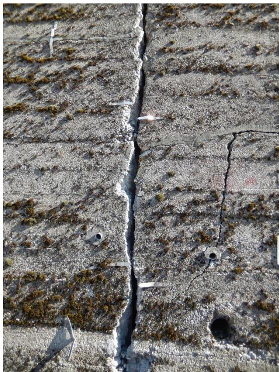
*Figura 36 Particolare di una frattura sul muro di sostegno a tergo del vecchio tracciato ferroviario. Foto dello scrivente datata 06/04/2018.*
