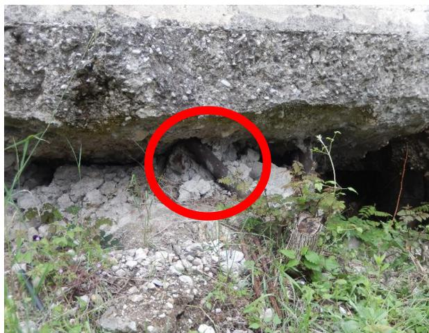
*Figura 121 Micropalo del deformato del cordolo tirantato del 1992. Foto dello scrivente del 29/05/2018.*
