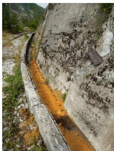
*Figura 174 Impermeabilizzazione della fratture sul muro a tergo del vecchio tracciato ferroviario con resine espansive per opera della Regione del Veneto nell'estate 2018. Foto dello scrivente del 06/09/2018.*
