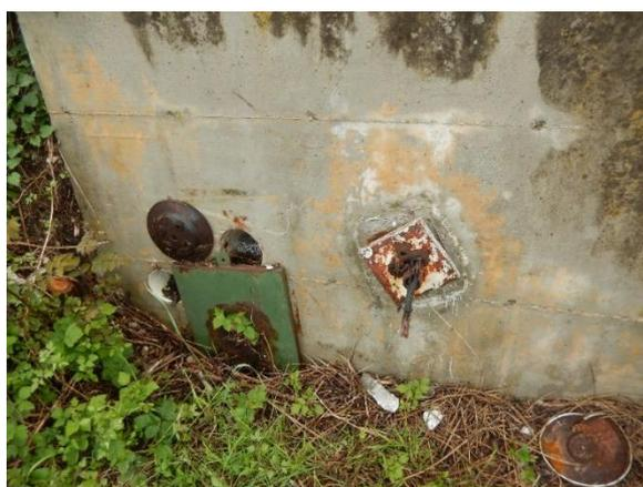
Figura 167 Tiranti non più in funzione della berlinese del 1992. Foto dello scrivente del 24/05/2018.
