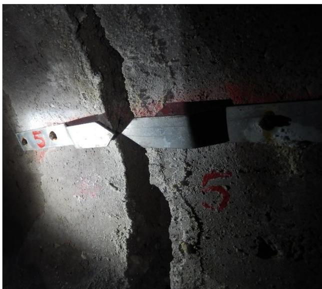
Figura 95 Fessurimetro su una frattura all'interno della galleria drenante e che mostra solo un esiguo movimento di tipo distensivo. Foto dello scrivente datata 06/09/2018.
