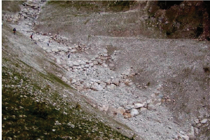
Figura 1 - Opere in massi consolidati con calcestruzzo nel bacino della Val della Vecchia. Fonte: D'Agostino V.
