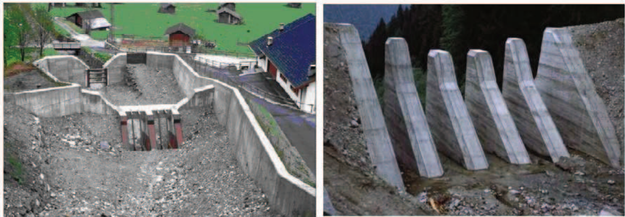
Figura 2 –Briglia di trattenuta (sx) e briglia frangi colata (dx). Fonte: D'Agostino V.
