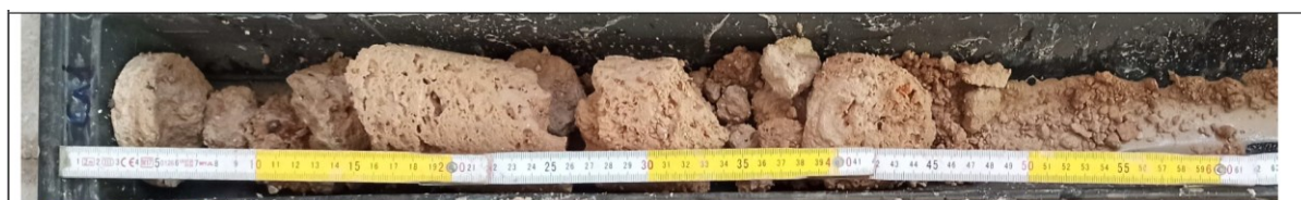
Figura 5.17 - Carota primo test, paramento interno primo livello. Lunghezza carota 45 cm.
