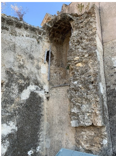
Figura 2.12 - Tamponamento dell'accesso esterno alla campanaria
