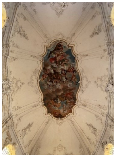
Figura 2.4 - Volta a padiglione affrescata
