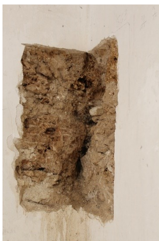
Figura 3.11 - Saggio visivo, ammorsamento muratura
