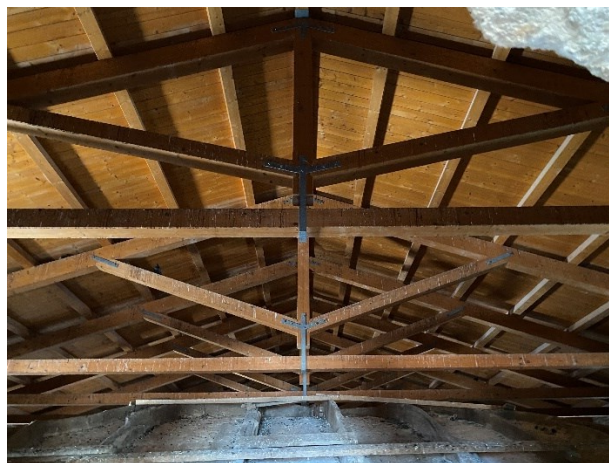
Figura 4.7 - Capriata copertura principale
