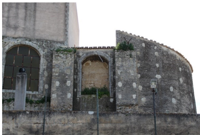
Figura 3.14 - Vista laterale, abside. Presenza di piantumazioni, depositi superficiali
