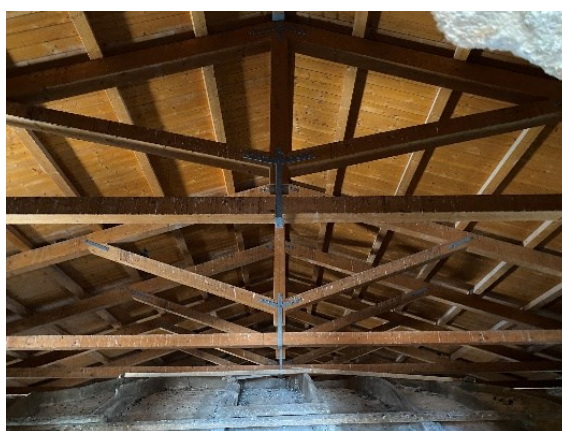
Figura 2.8 - Capriate lignee della copertura sopra la volta centrale
