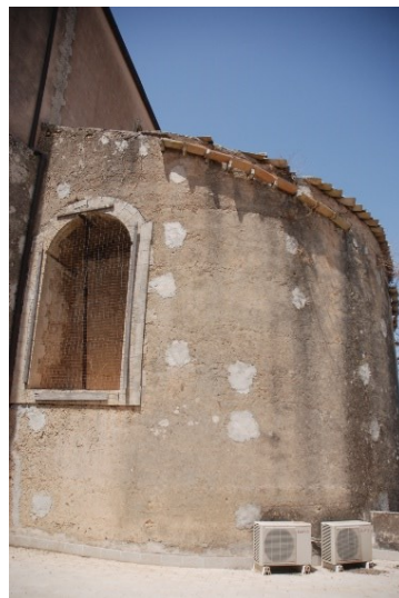
Figura 2.10 - chiusura della finestra dell'abside laterali
