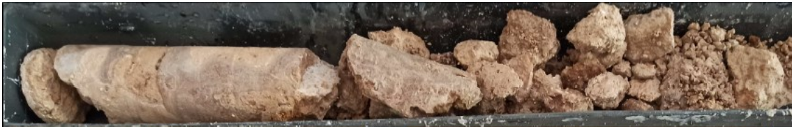
Figura 5.19 - Carota primo test, paramento interno primo livello. Lunghezza carota 70 cm.
