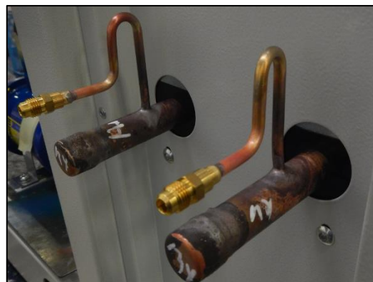
Figura 4.23: Prese di pressione saldate su circuito frigorifero (Fonte interna MEHITS)
