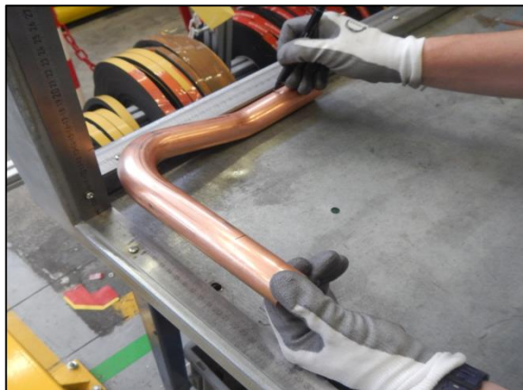
Figura 5.14: Banco di misurazione e segno delle tubazioni (Fonte interna MEHITS)
