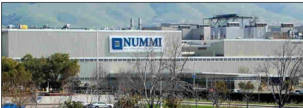
Figura 2.12: Lo stabilimento NUMMI di Fremont, California
