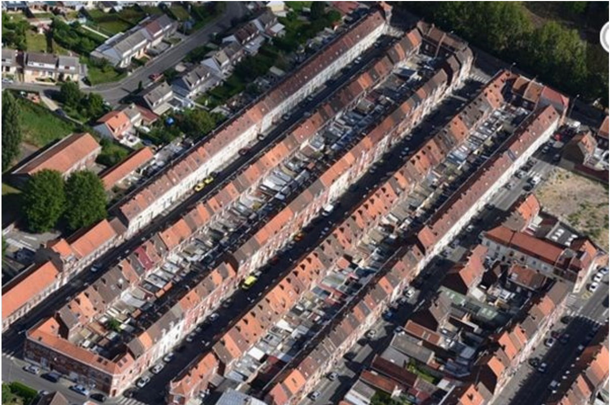
Auteur inconnu, vue aérienne du quartier ouvrier, 2017
