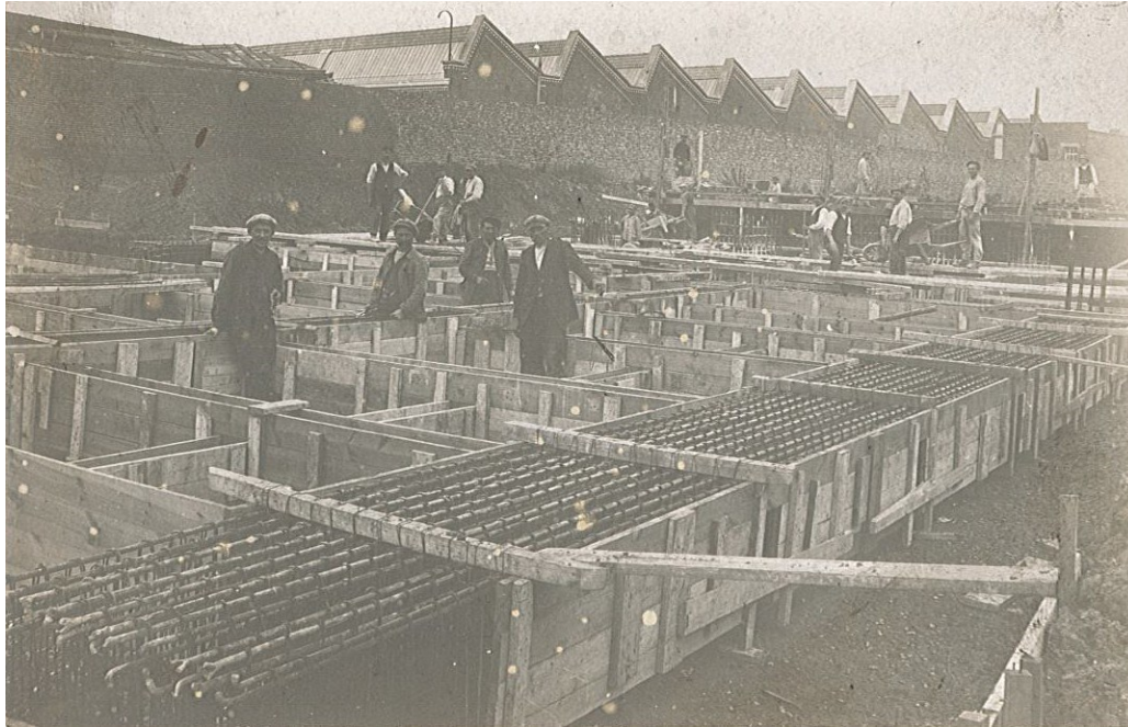
Auteur inconnu, Construction du grand hall de la brasserie Motte-Cordonnier, 1923, photographie, archives municipales de la ville d'Armentières, 4Fi0497
