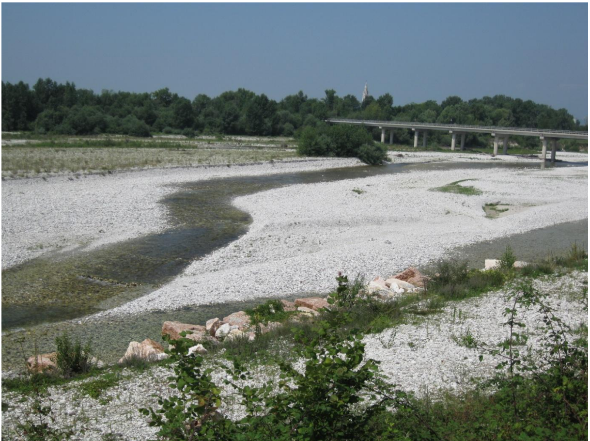
Figura 25 : Veduta del fiume Brenta a Nove.
