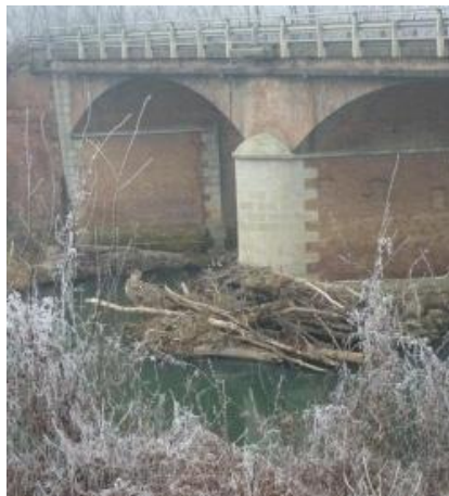
Figura 44 : Diga detritica naturale fra le colonne di un ponte.
