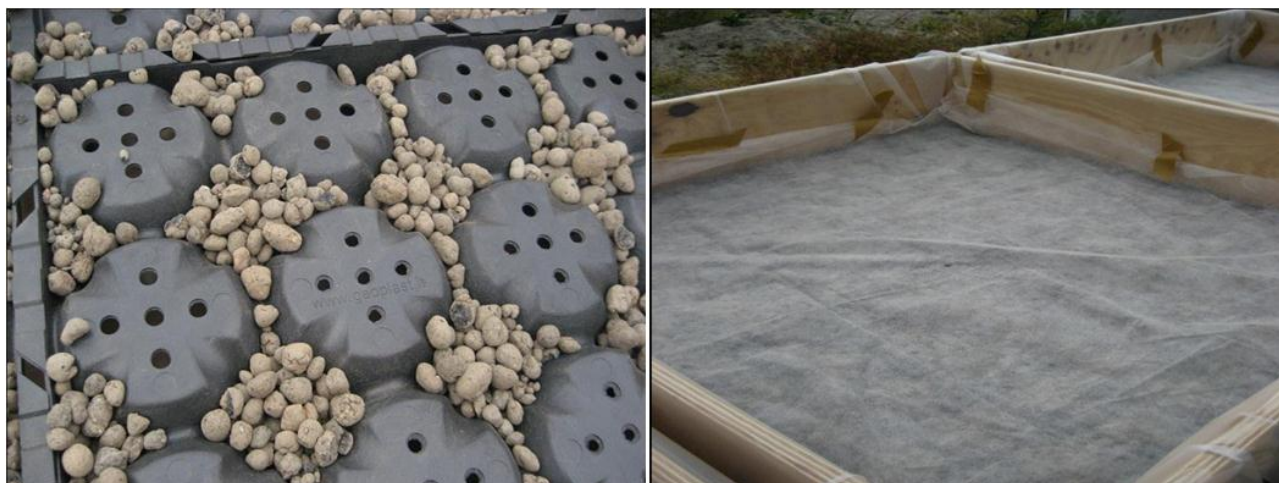
Foto 4: a) Argilla espansa; b) Tessuto non tessuto (strato filtrante)
