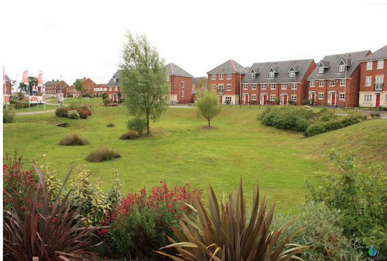
Figura 4.7: Esempio di bacino di detenzione ( www.sudsdrain.com )
