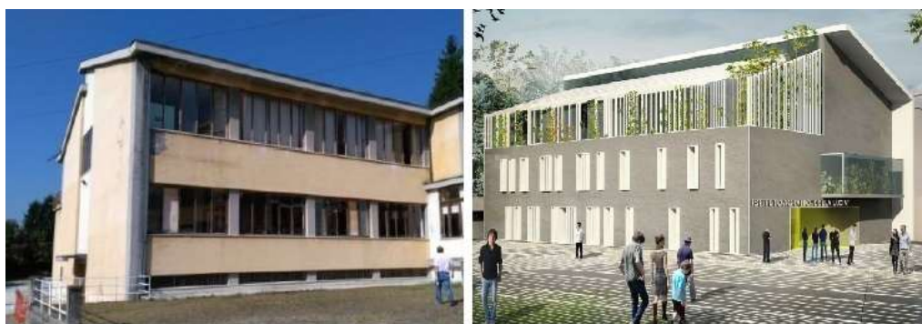
Figura 3.1 Rappresentazione dell'edificio pre (sinistra) e post (destra) ristrutturazione.
