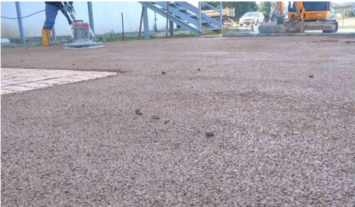
Figura 3 - Posa di calcestruzzo stabilizzato drenante
