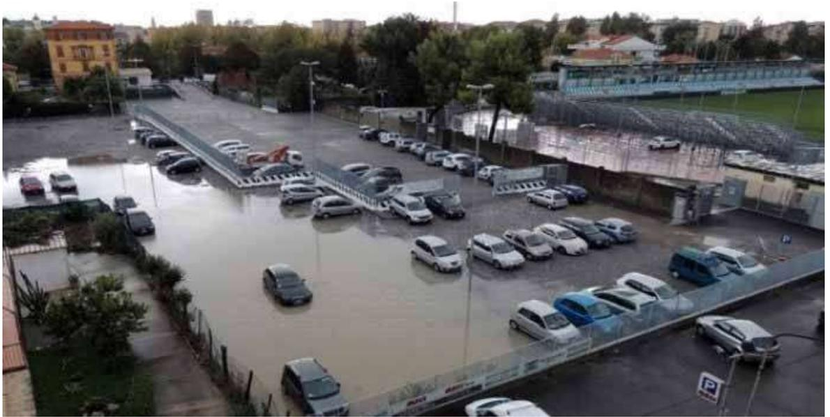
Figura 2 - Fotografia di un parcheggio con sottofondo non drenante
