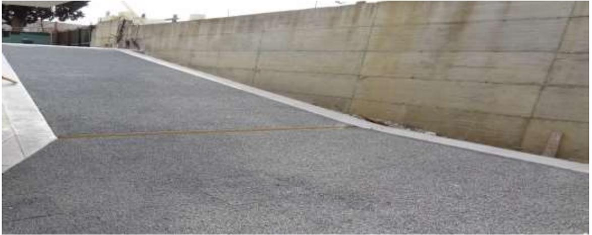
Figura 4 - Rampa in calcestruzzo stabilizzato drenante
