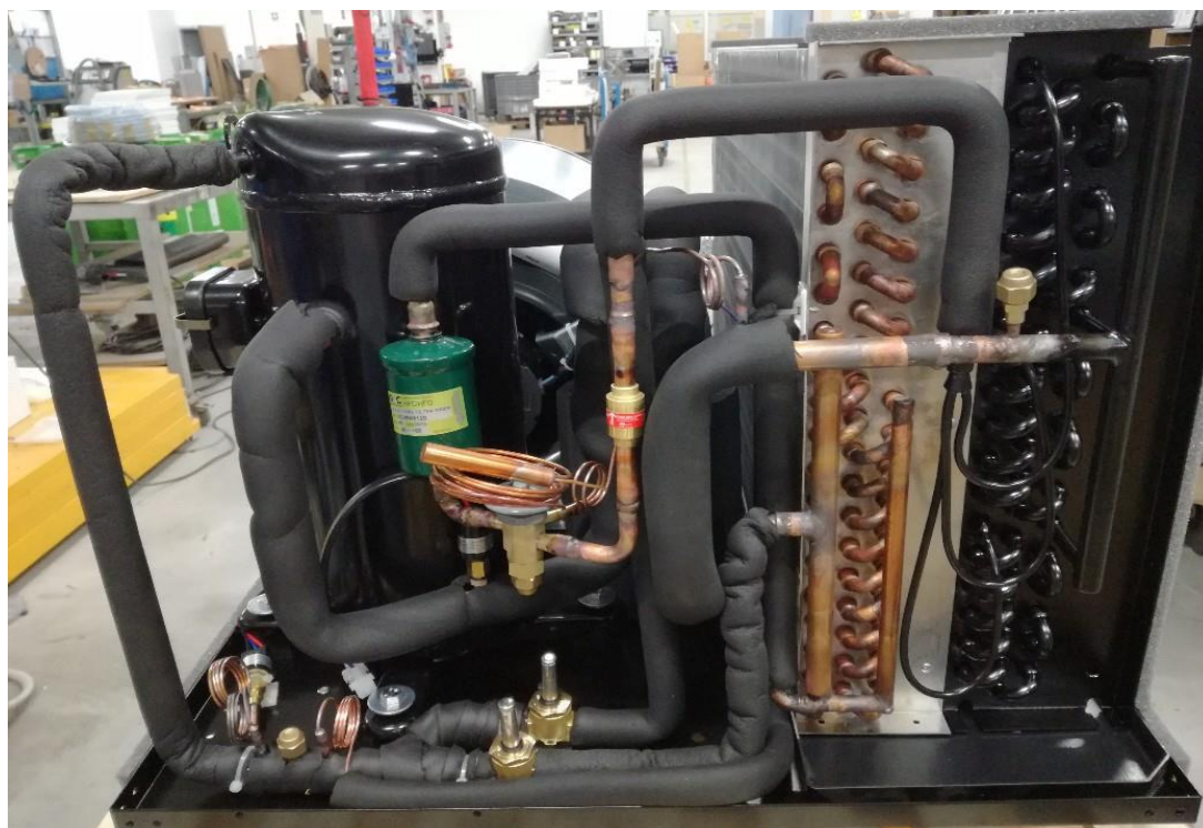
Fig. 4.1. Una visuale laterale di una macchina in costruzione col circuito frigo completato
