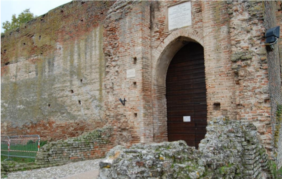
Foto 16. Davanti all'ingresso del castello sono ancora presenti i resti delle mura laterali del rivellino, mentre più avanti, prima dell'ingresso ad arco, si vedono ancora i passanti della saracinesca.
