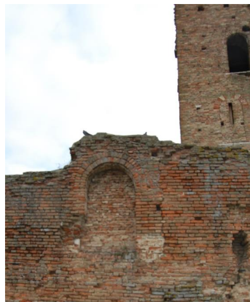
Foto 13. Ingresso a volta dal quale si accedeva direttamente alla Rocca senza passare per la torre d'ingresso del castello.
