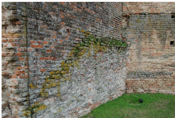
Foto 15. Segno visibile, nell'angolo tra il lato destro della torre d'ingresso e la cinta muraria, della presenza passata di un terrapieno.
