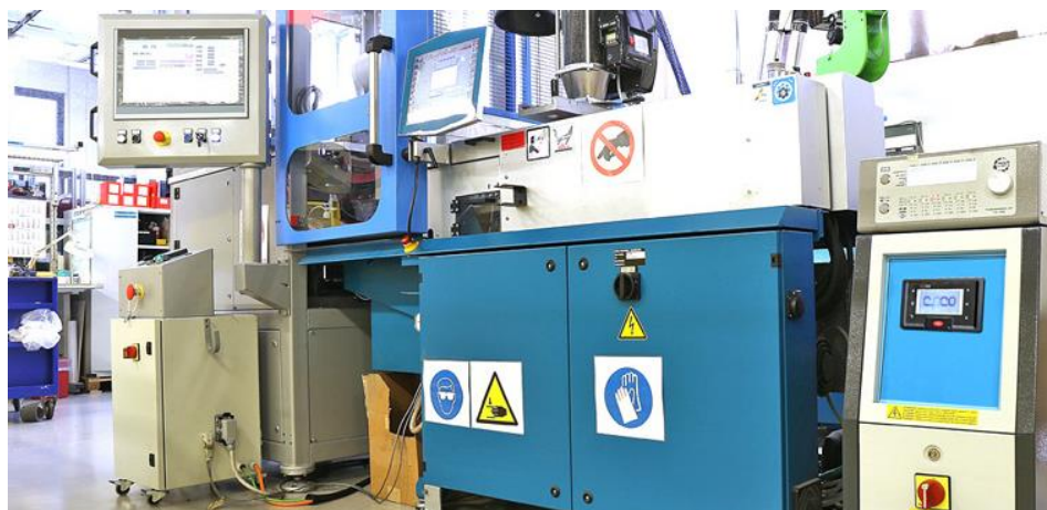
Figura 1.14 – Unità di termoregolazione con controllo Carel (fonte: Carel Industries S.p.A, 2019)
