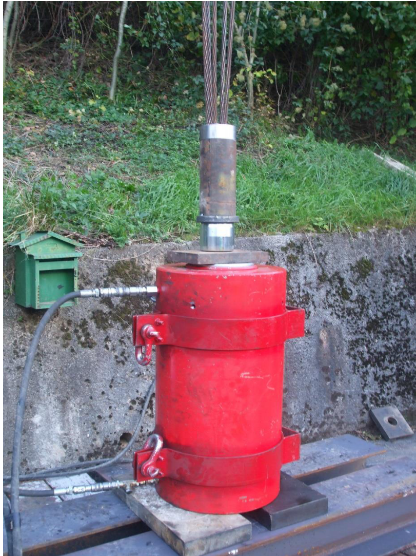
Foto 4.4, Strumentazione posizionata per pull out su ancoraggio I
