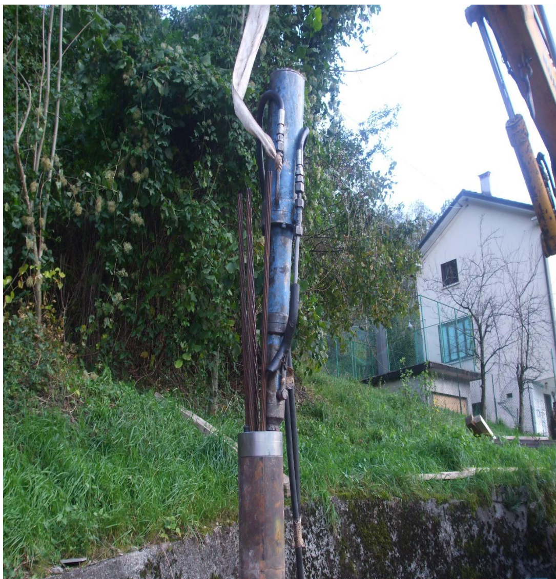
Foto 4.3, Pistone durante la fase di pre-tensione dei trefoli
