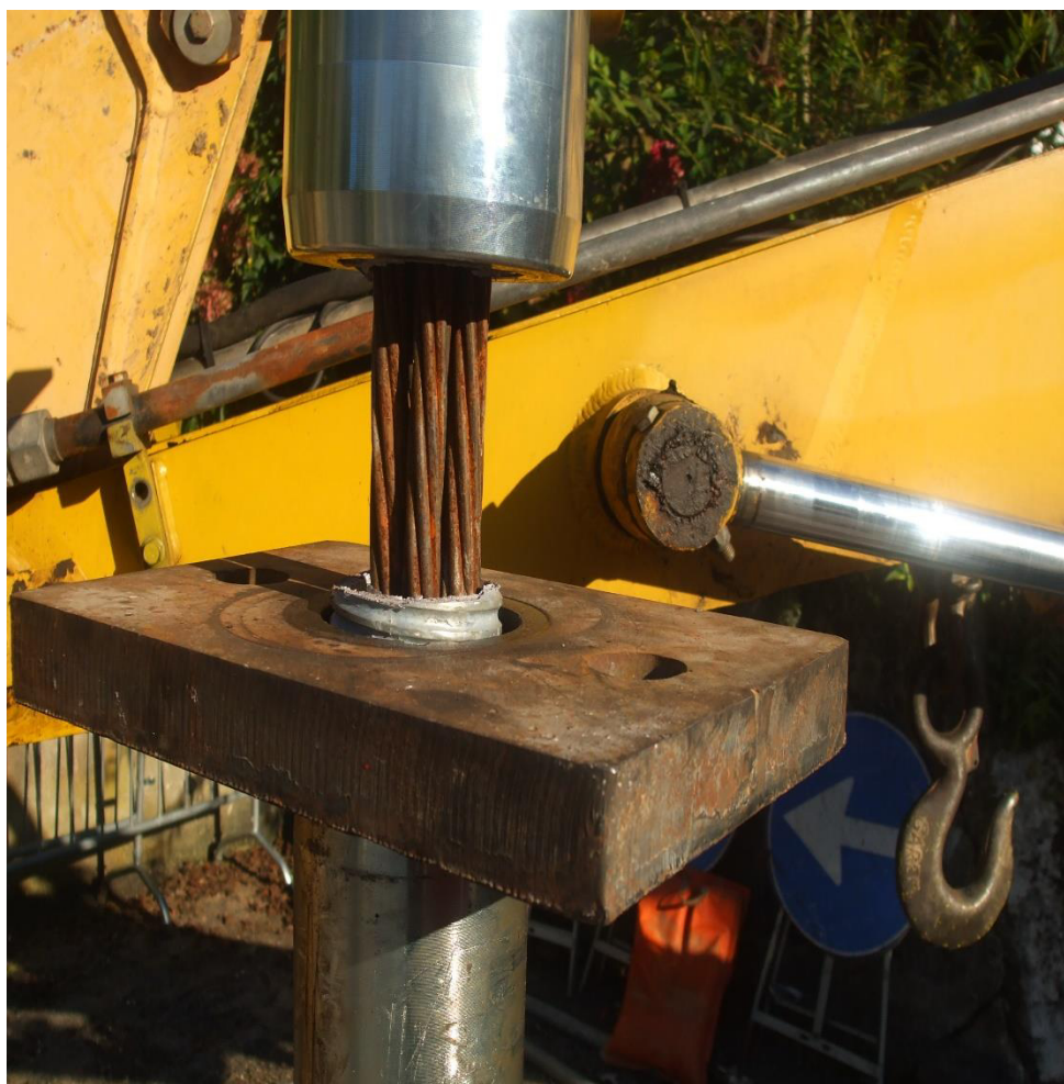
Foto 4.8, Rottura barra ancoraggio III
