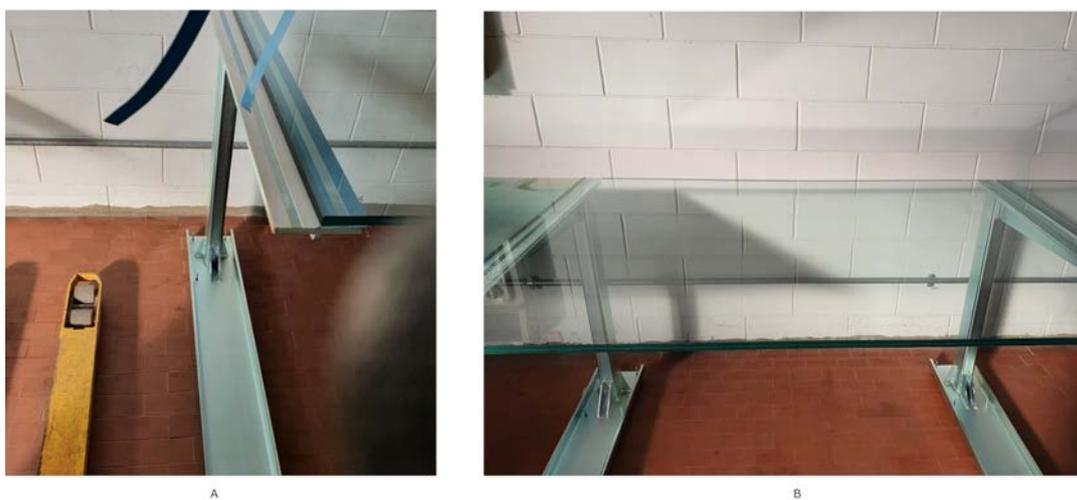
Figura 23: Collegamento del vetro ai supporti tramite l'adesivo: A) rimozione della protezione alle strisce biadesive; B) lastra incollata.
