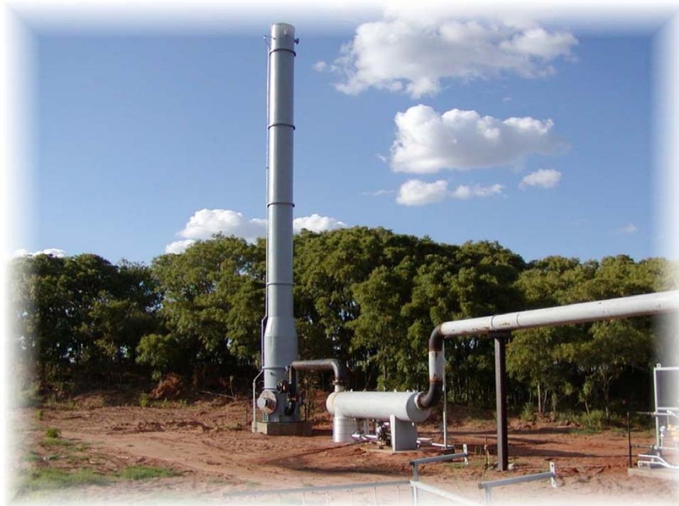
Figura 8.3 - Sistema di torcia fredda
