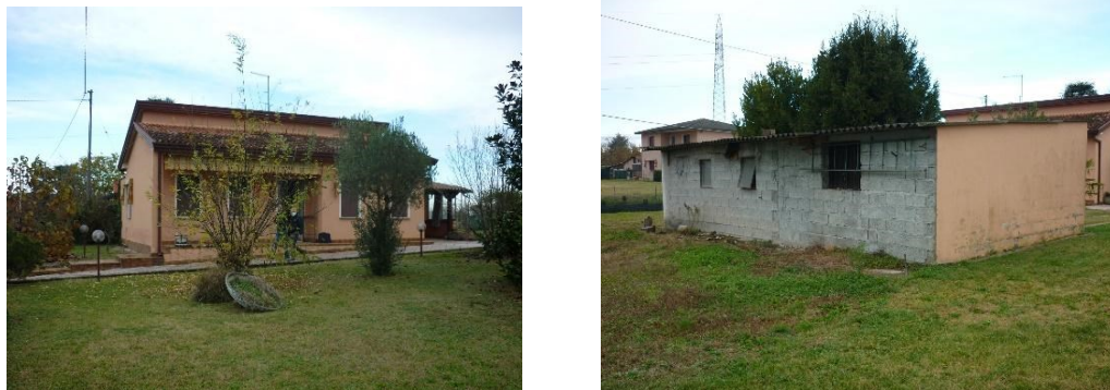
Figura 2: Prospetto sud abitazione e prospetti est-sud annesso
