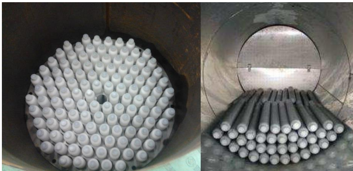
Fig.5.8 Tubi con PCM S46 nel serbatoio di accumulo reale.
