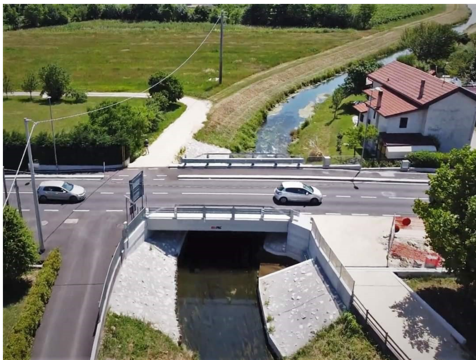
Figura 14: Ponte via XXX Ottobre al termine dell'intervento. (Fonte: Anbi Veneto)
