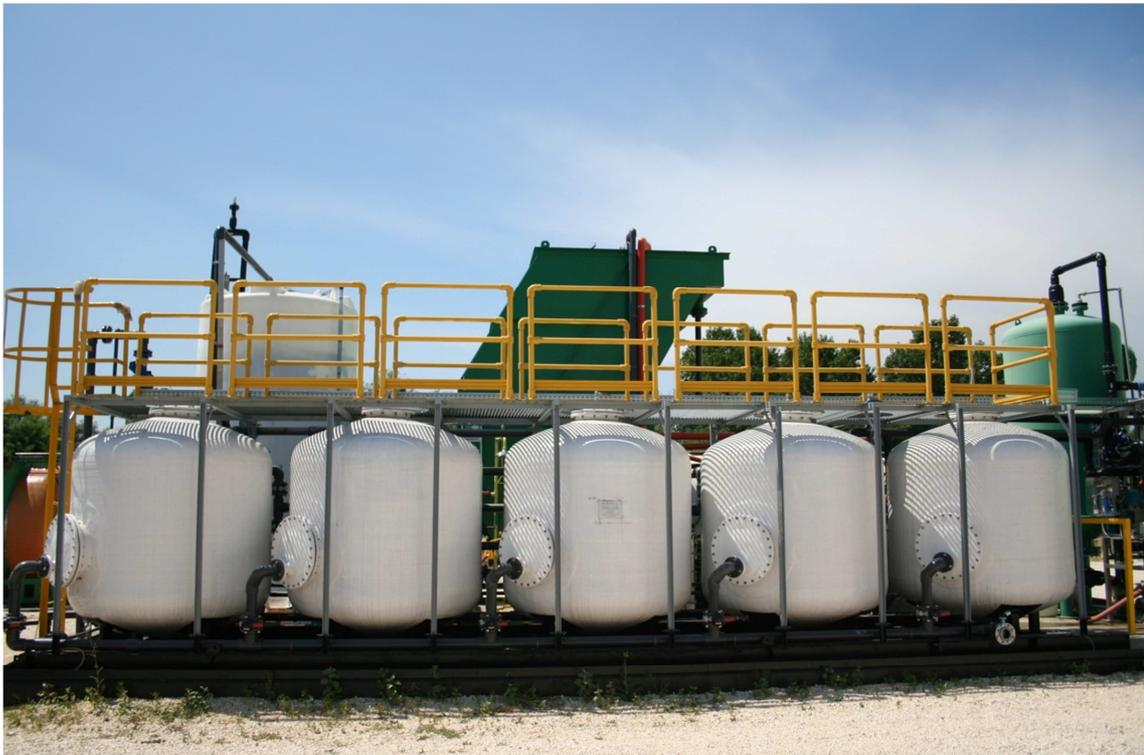
**Figura 4.5** Foto della batteria dei 5 filtri a carboni attivi
