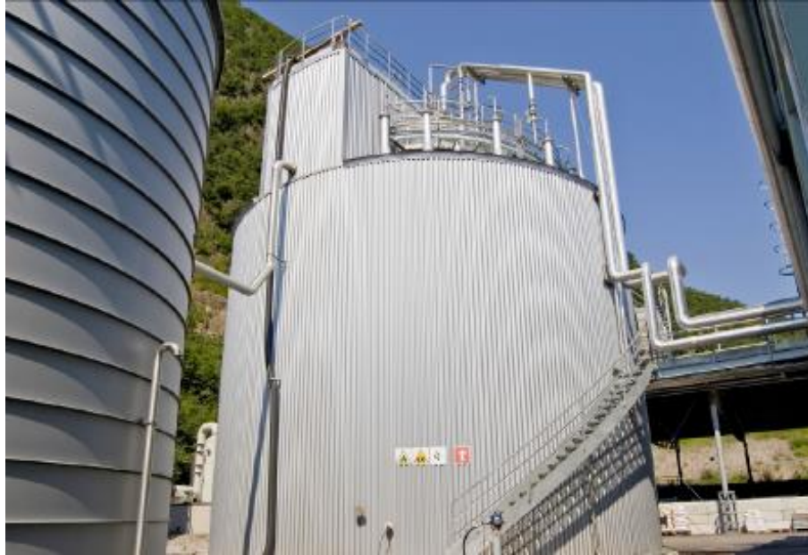
Figura 6: Il bioreattore nell'impianto di Lana
