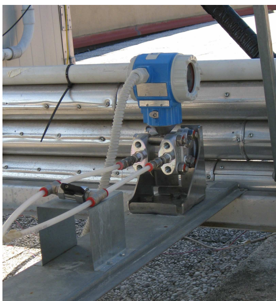
Figura 2.6 – Misuratore di pressione differenziale
