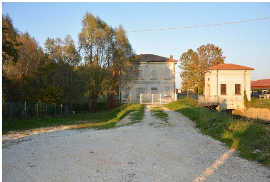
Fig. 2.6 - Torre dei Burri; si nota come il terreno attorno sia depresso rispetto al sostegno
