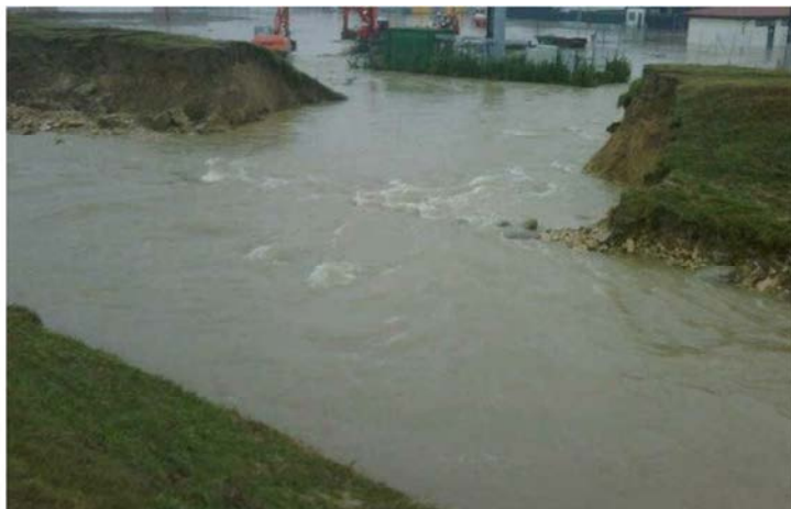
Fig. 2.4 - Rotta dell'argine del Muson del 2009 nel comune di Loreggia
