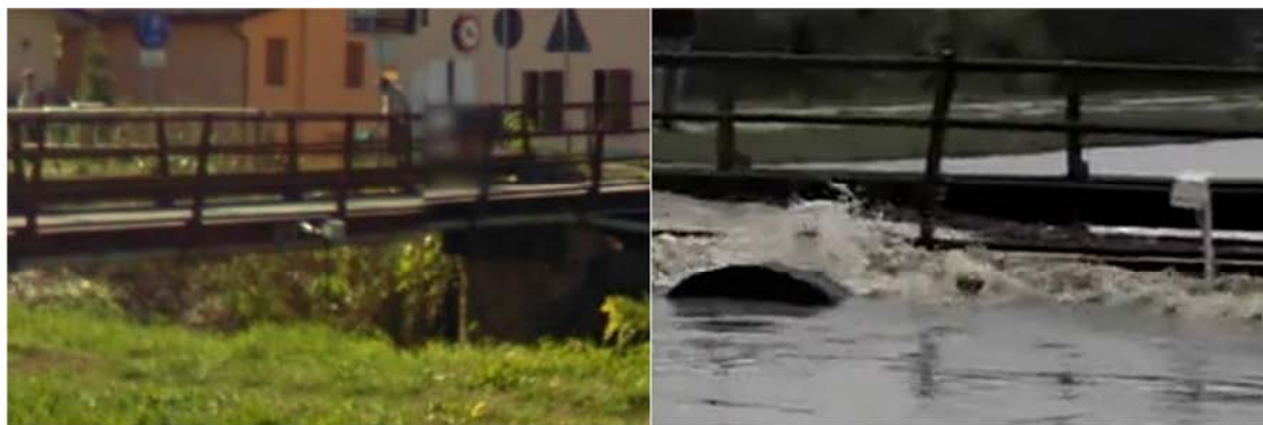
Fig. 3.10 Sollevamento dello strumento di rilevazione al ponte di ferro a Camposampiero
