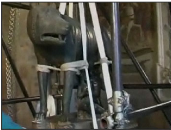
Fig. 6 - Sollevamento della lupa capitolina inglobata all'interno di un trabattello (da https://www.minguzzionline.com/documenti/lup2.jpg )
