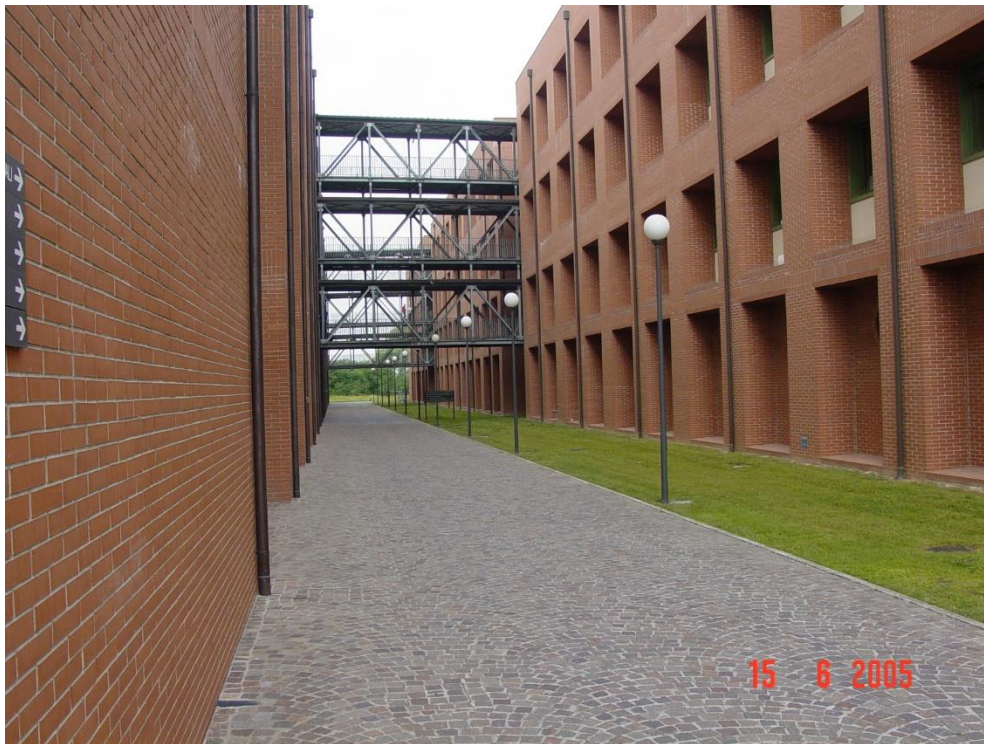
Figura 3 Vista esterna edificio stecca 1
