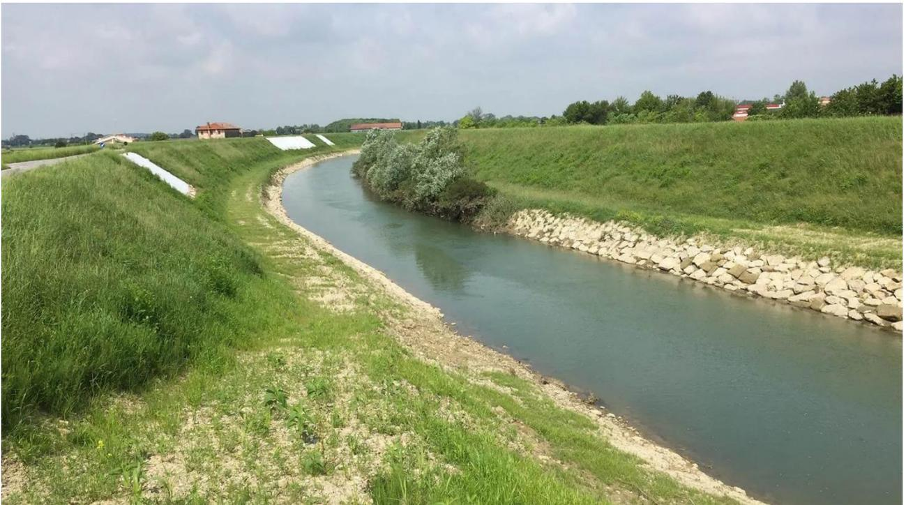
*Figura 1-Esempio di Argine*
