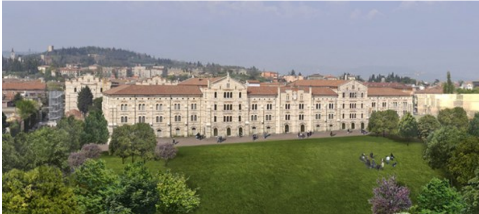
Figura 11 Complesso ex panificio
