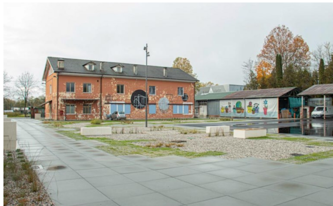
Figura 8 Lavori finiti nell'area esterna
