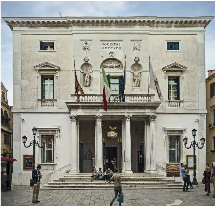
Fig.6 Facciata del Gran Teatro la Fenice.
