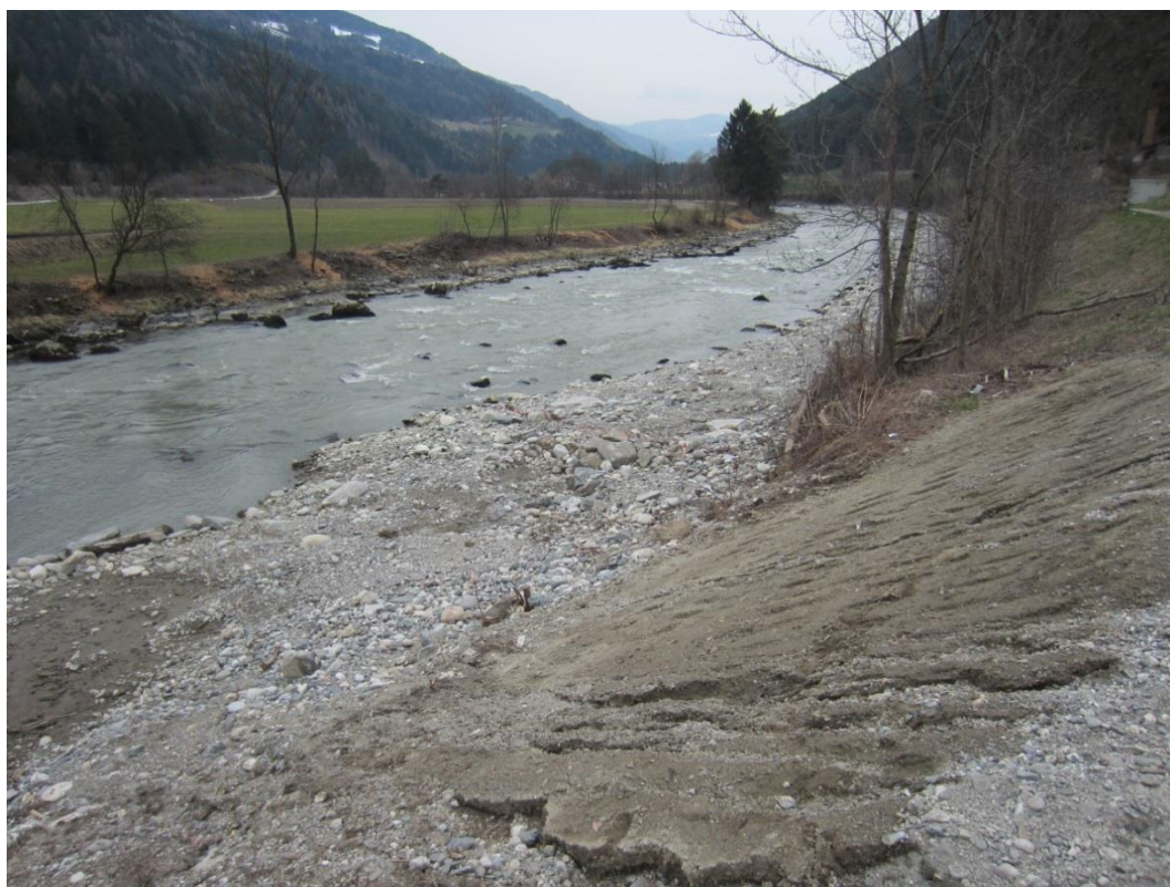
Figura 5 Localizzazione della barra artificiale, si nota la sua disposizione laterale in destra idrografica con l'accesso utilizzato per i lavori di messa in posto. E' interessante notare anche il livello del Rienza equivalente ad una portata di circa 30m 3 /s.
