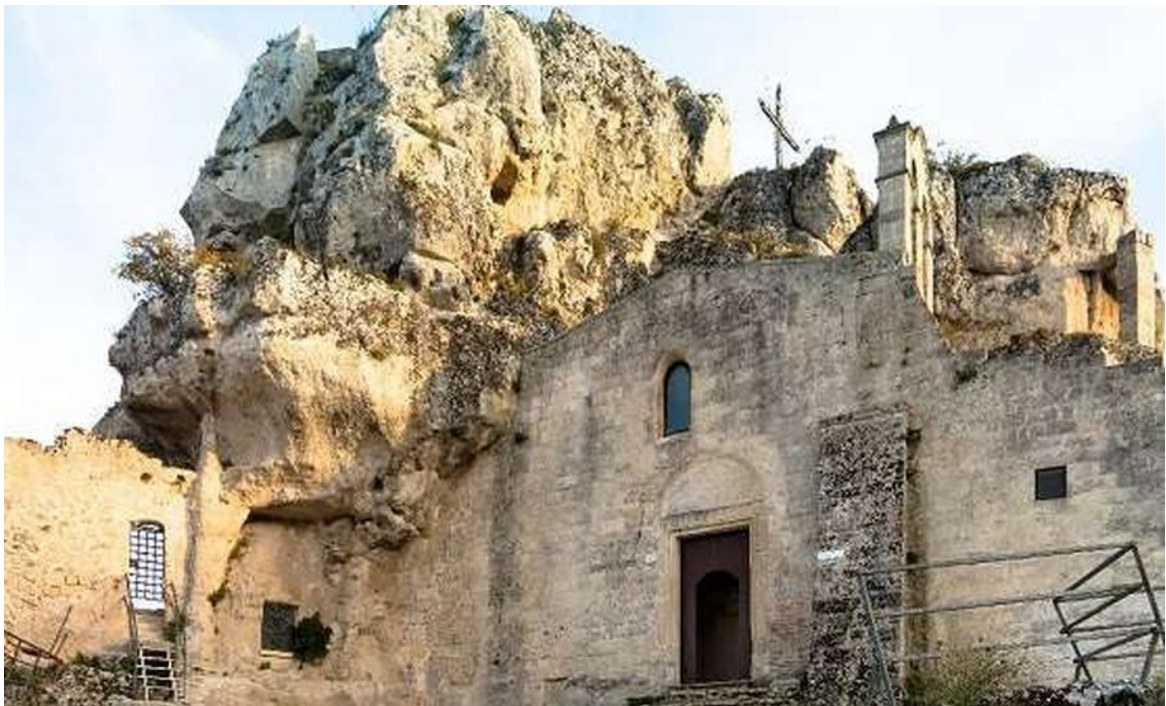
3. Matera, Chiesa di San Giovanni in Monterrone.
