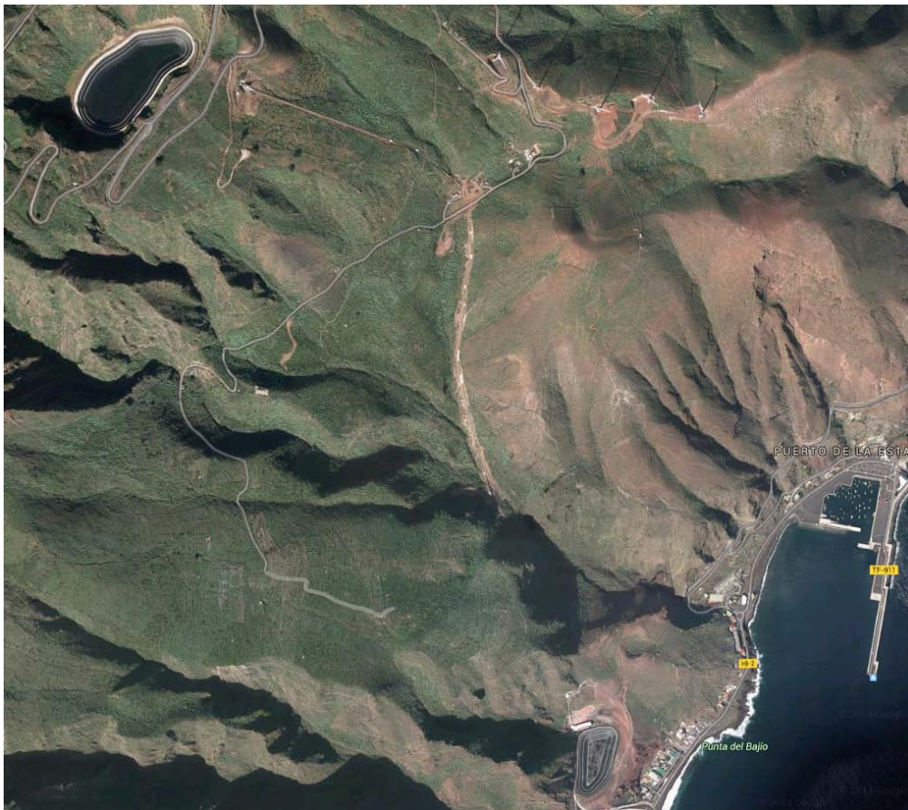
Figura 3.9: Veduta aerea dell'impianto idroelettrico di pompaggio dell'isola Spagnola El Hierro .
