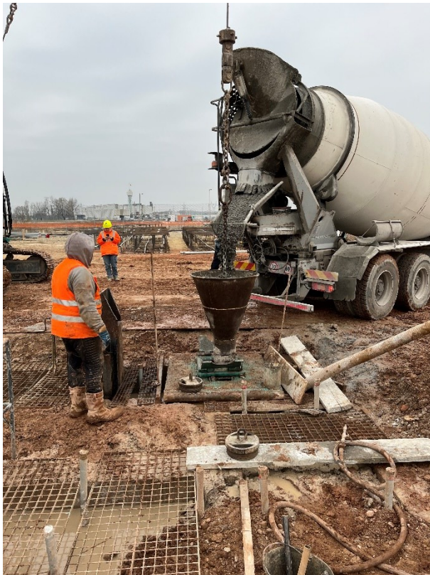
Figura 22: Fase di getto del diaframma in calcestruzzo e risultato della prova con il cono di Abrams per definire la classe di lavorabilità del calcestruzzo.
