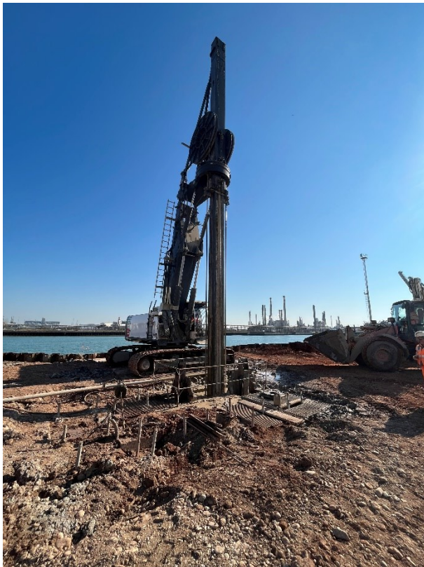
Figura 17: Scavo pannelli di diaframma con gru cingolata Kelly Casagrande C400 e benna mordente, dotata di sensore di misurazione JEAN LUTZ S.A .
