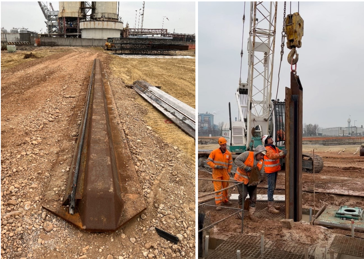
Figura 21: Giunto waterstop inserito all'interno di apposite palanca sagomata e immersione all'interno dello scavo per il posizionamento prima del getto.
