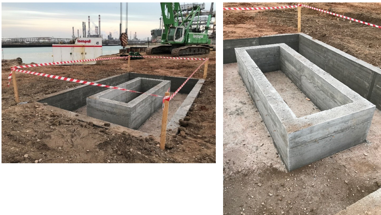
Figura 16: Cordoli guida, o corree, di sezione B 20 cm x H 80 cm, con piano di posa alla quota di +0.70 m s.l.m., su uno spessore di magrone di 10 cm.
