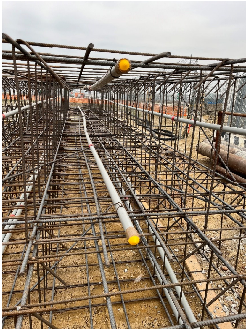
Figura 20: Particolare delle gabbie di armatura fornite in cantiere preassemblate, con la predisposizione dei tubi sonici in PVC per l'esecuzione delle prove cross-hole.
