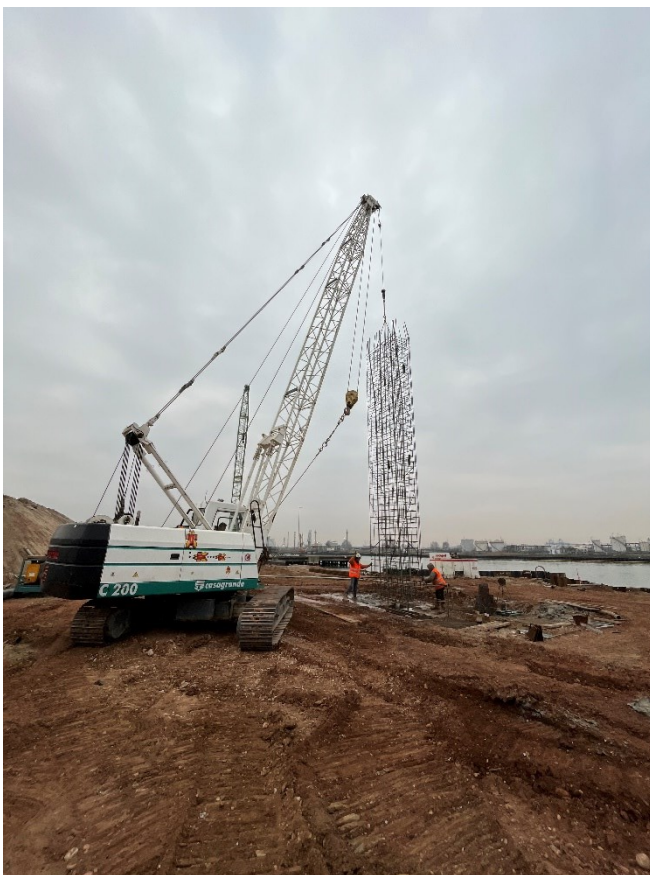
Figura 19: Sollevamento e introduzione della gabbia di armatura all'interno dello scavo sostenuto dai fanghi bentonitici.
