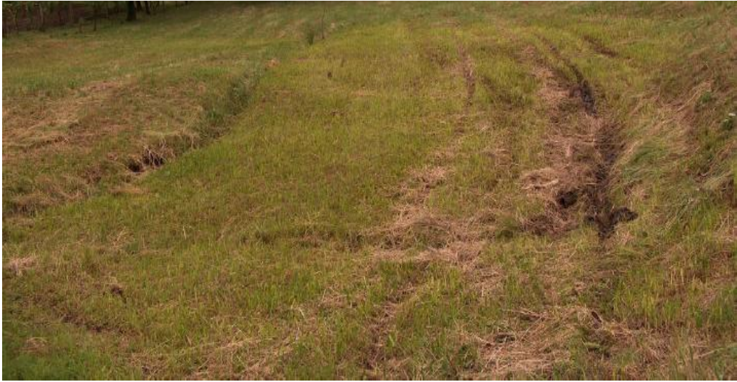
Foto 8 – Fenomeni gravitativi superficiali rilevati nel settore 2 del versante instabile.
