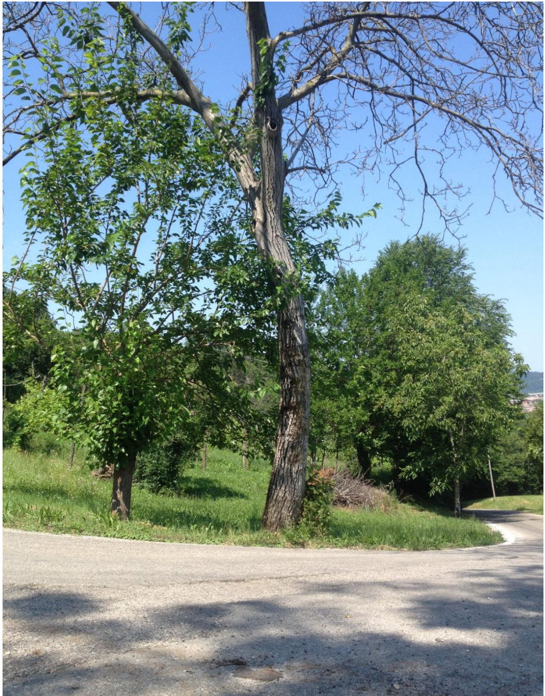
Foto 7 – Deformazione del tronco di un albero legata a fenomeni di instabilità superficiale.
