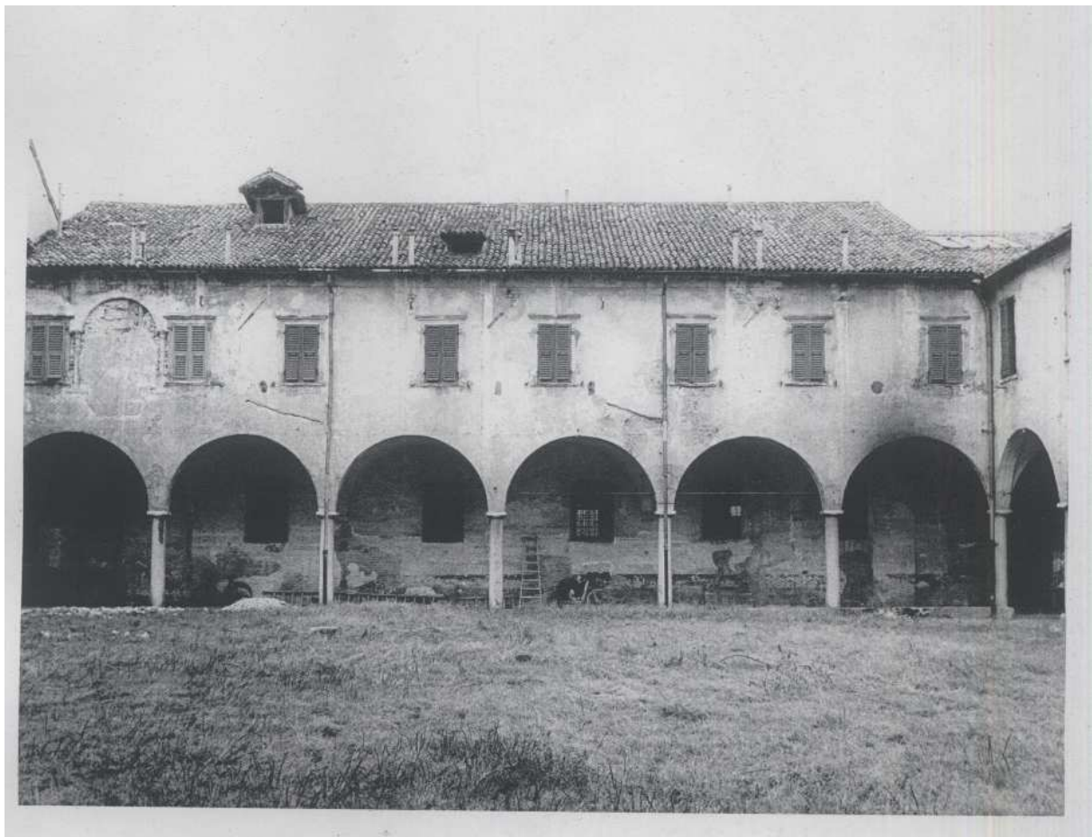
Fig.[1.53] Vista della facciata Ovest del Chiostro Maggiore.
