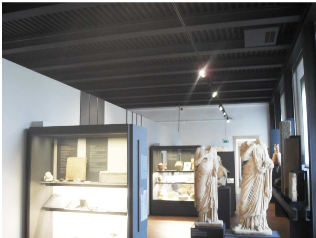
Fig.[2.25] Lato Orientale dei Chiostri, nel particolare il solaio costituito da una struttura d'acciaio.
