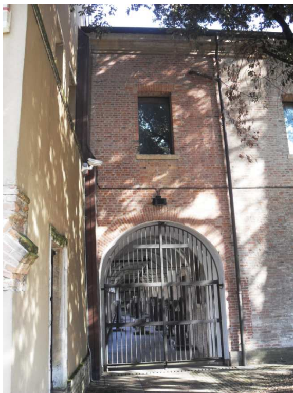
Fig.[2.4] Vista del prospetto Ovest, nel particolare l'entrata al Chiostro Maggiore.
