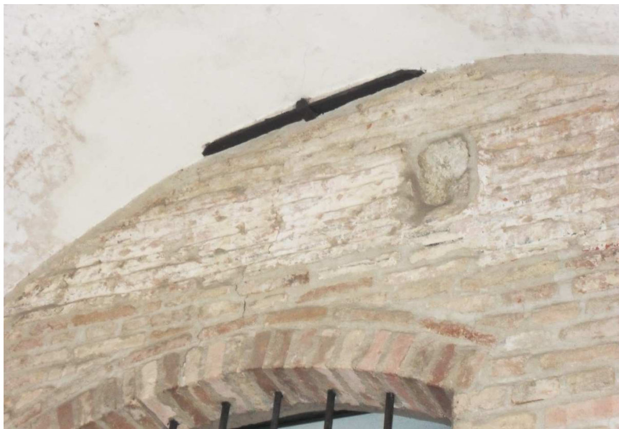
Fig.[5.59] Tirante situato nel portico Ovest del Chiostro Maggiore.
