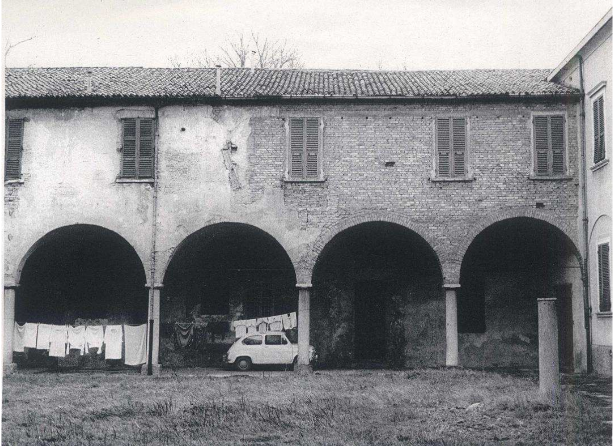
Fig.[1.54] Vista della porzione destra della facciata Nord del Chiostro Maggiore.
