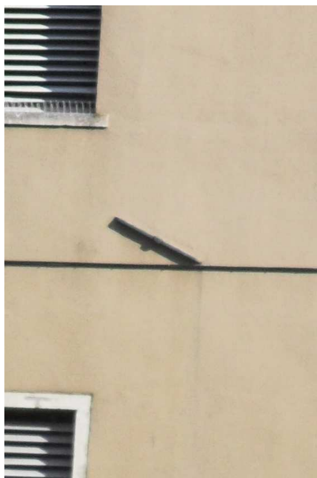
Fig.[5.54] Tirante situato nella facciata ovest.
