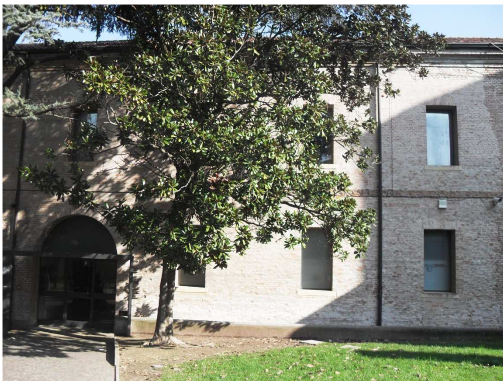
Fig.[2.3] Vista del prospetto Ovest, nel particolare l'ingresso ai Musei Civici.
