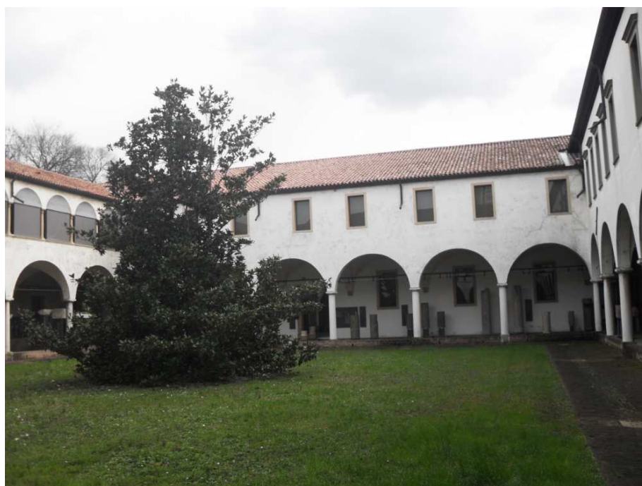
Fig.[2.16] Vista d’insieme del Chiostro Maggiore, con particolare del portico Est ricostruito.
