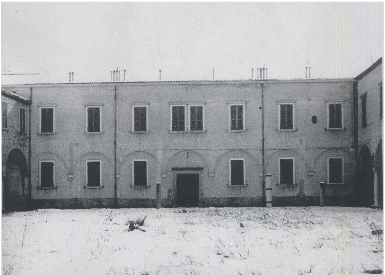
Fig.[1.55] Vista della facciata Est del Chiostro Maggiore.
