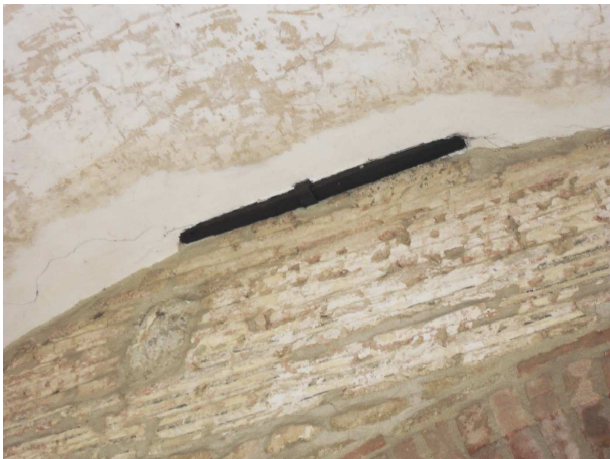
Fig.[5.58] Tirante situato nel portico Ovest del Chiostro Maggiore.
