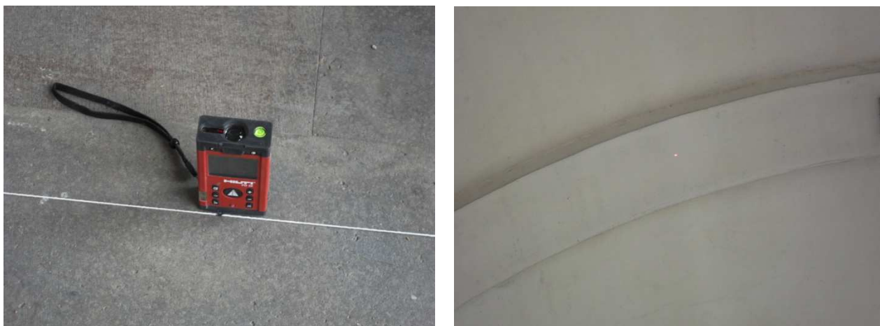
Fig.[3.9 – 3.10] Misura della distanza dalla base all’arco della volta soprastante
