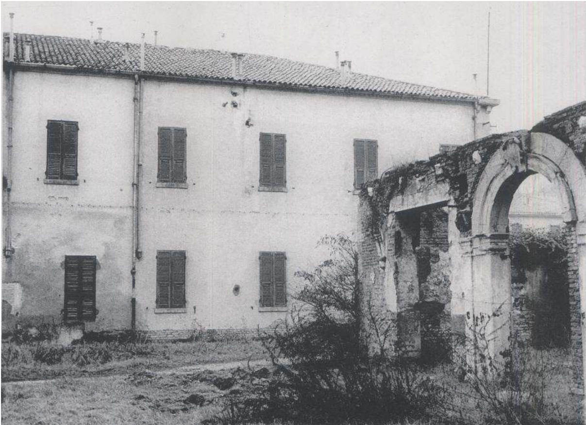
Fig.[1.63] Vista della porzione destra della facciata Nord del Chiostro Minore.
