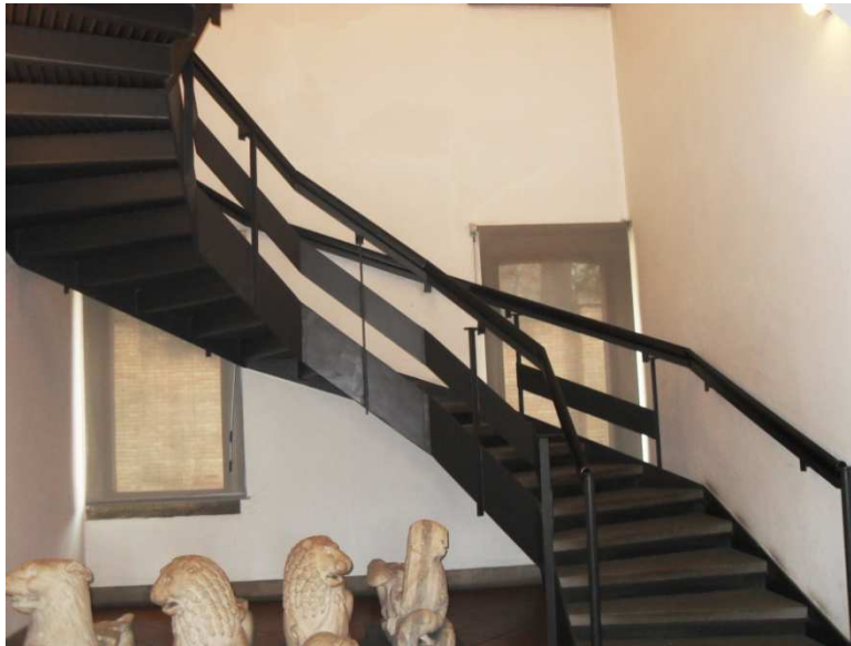
Fig.[2.20] Scala elicoidale in metallo eseguita nel restauro degli anni '70.
