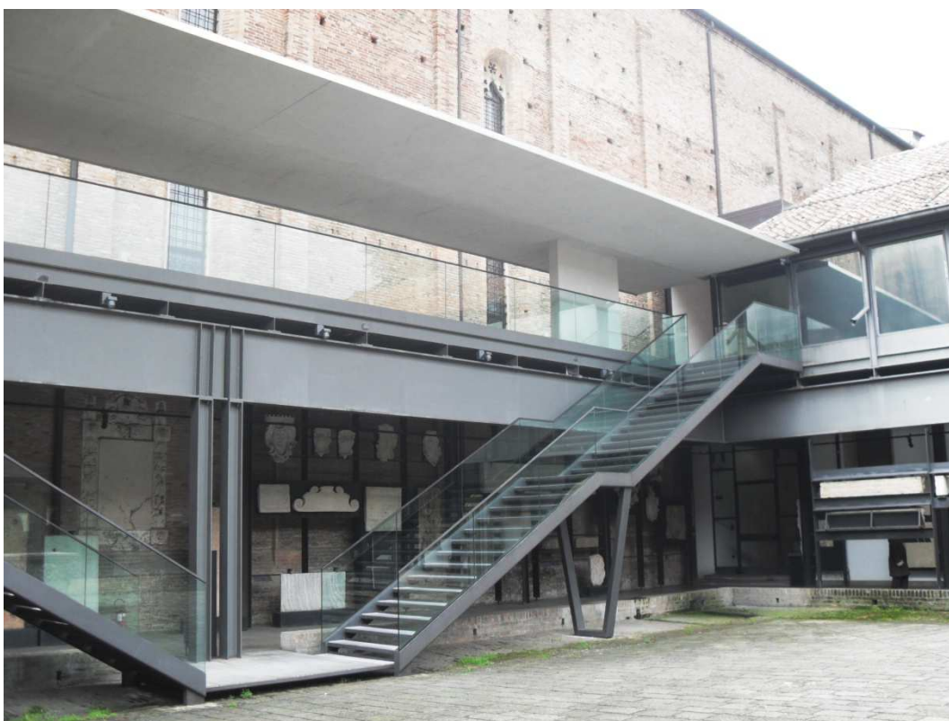
Fig.[2.31] Vista della “passerella” che congiunge il lato est e il lato ovest del Chiostro Minore.
