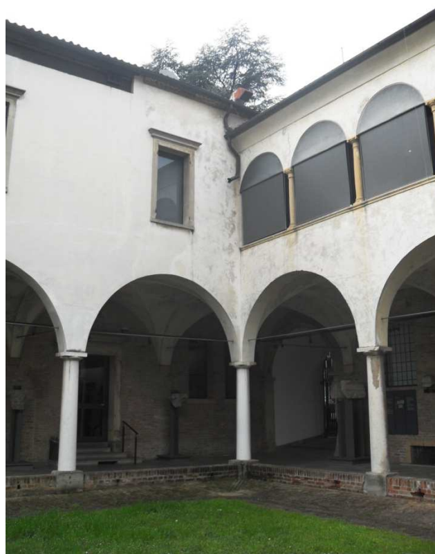
Fig.[2.19] Nel particolare l'interfaccia di giunzione fra il prospetto Ovest e il prospetto Sud del Chiostro Maggiore.
