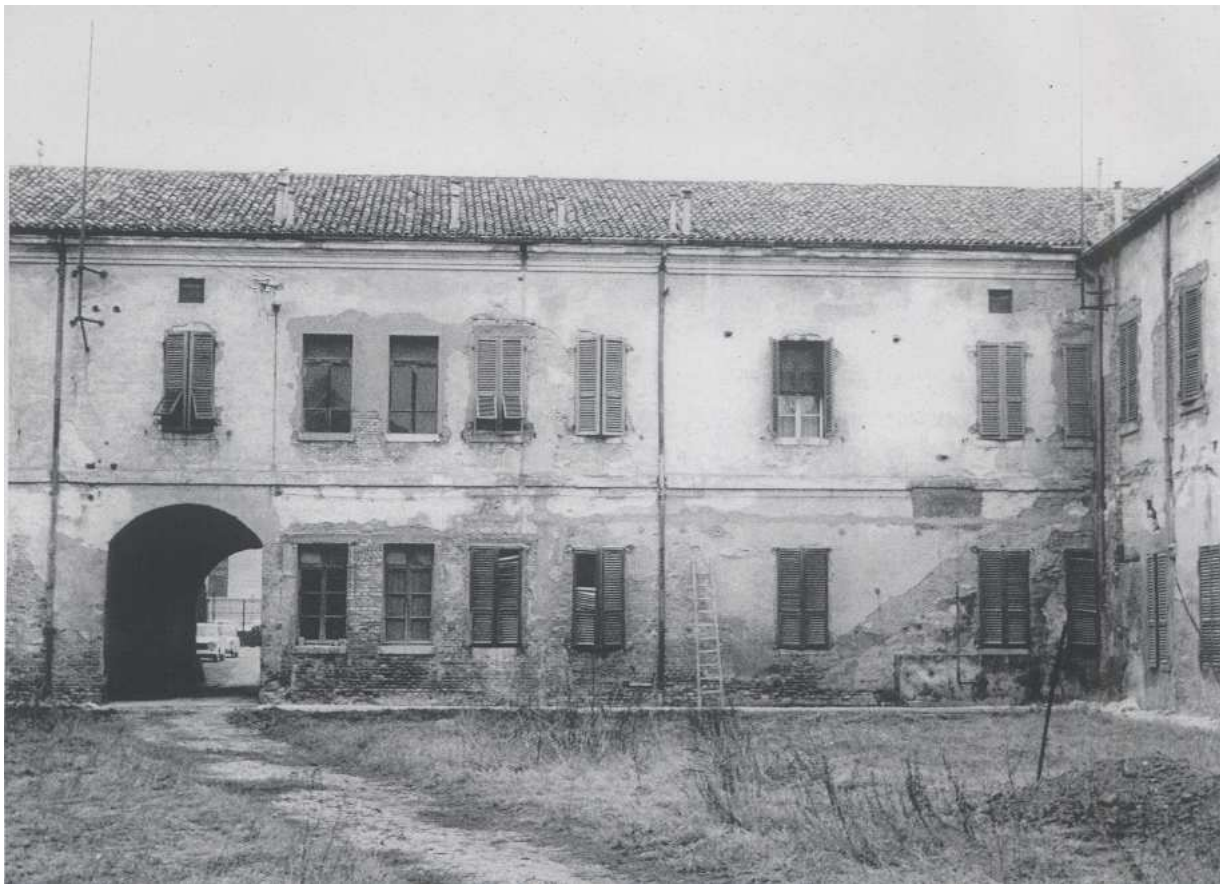
Fig.[1.60] Vista della porzione destra della facciata Ovest del Chiostro Minore.
