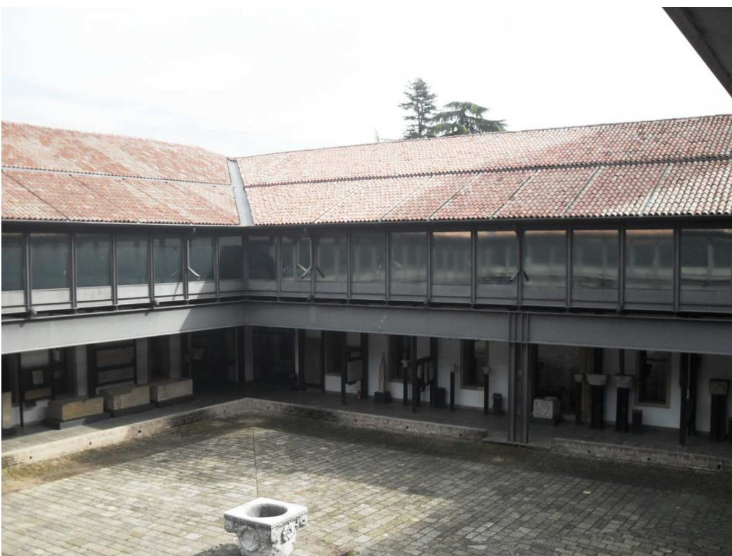
Fig.[2.32] Vista da Sud-Est al primo piano del Chiostro Maggiore.
