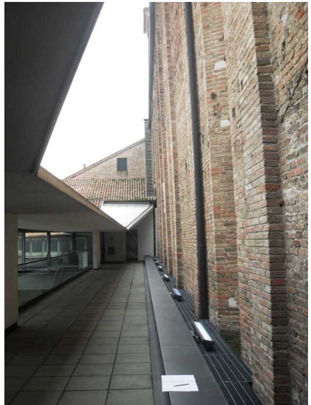
Fig.[2.35] Vista dal piano primo della "passerella".
