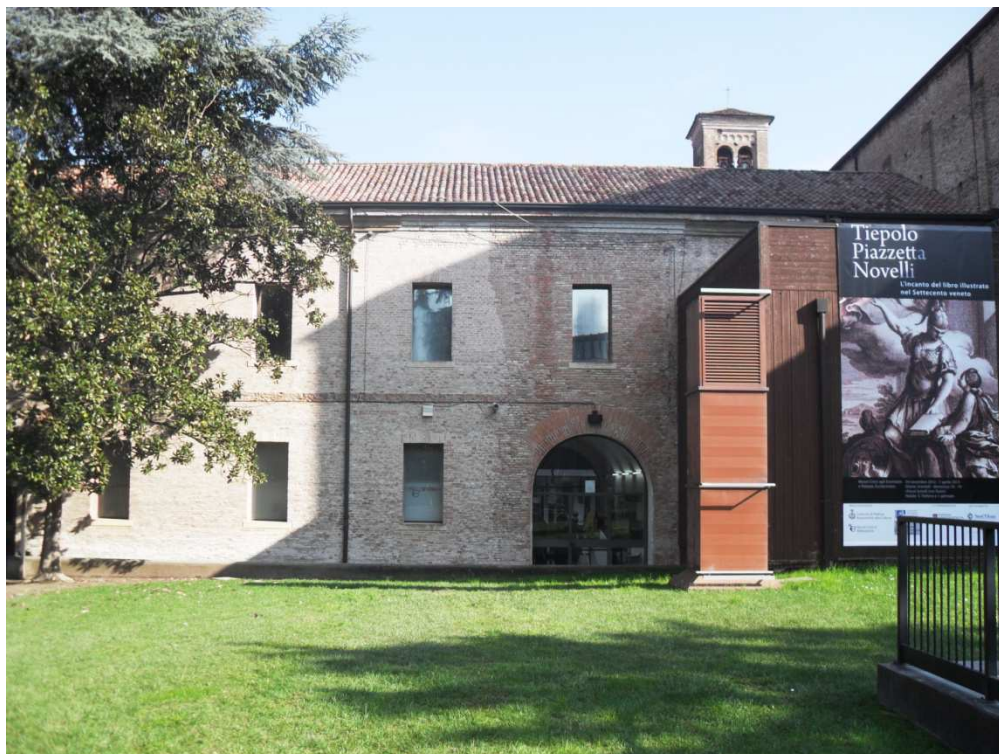
Fig.[2.2] Vista del prospetto Ovest con l'entrata al locale bar.
