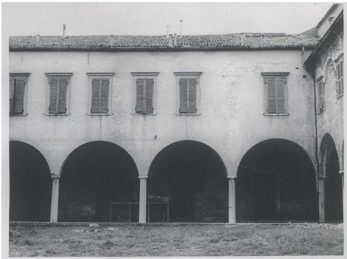
Fig.[1.58] Vista della porzione destra della facciata Sud del Chiostro Maggiore.
