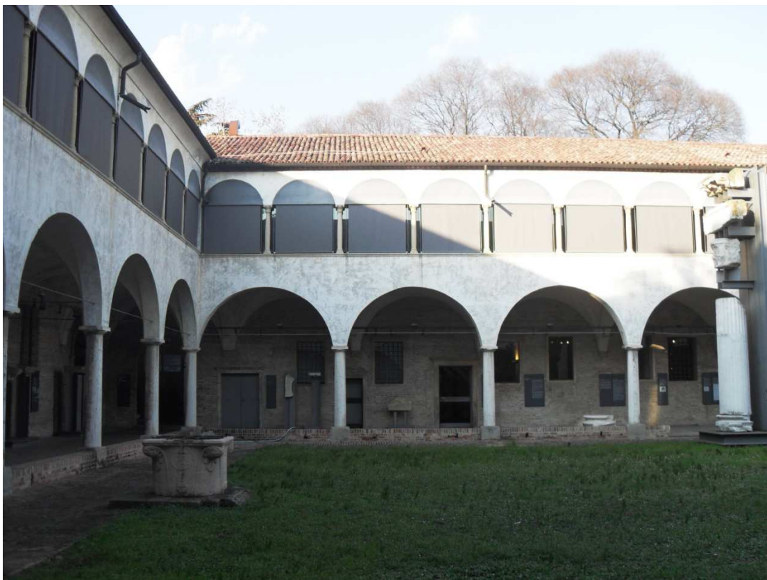
Fig.[2.17] Vista del prospetto Nord e Ovest, nel particolare si nota il loggiato superiore riaperto dopo il restauro degli anni '70.
