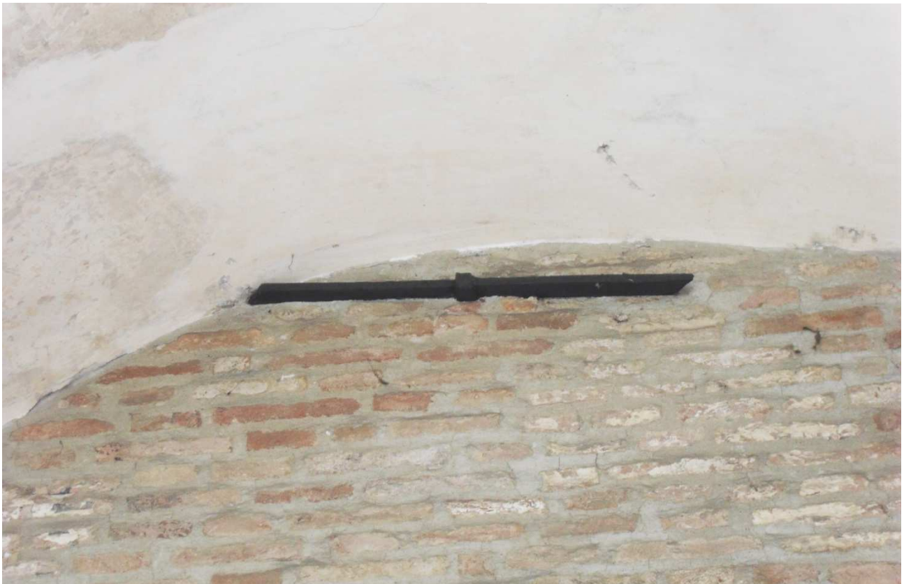
136 Fig.[5.57] Tirante situato nel portico Ovest del Chiostro Maggiore.
