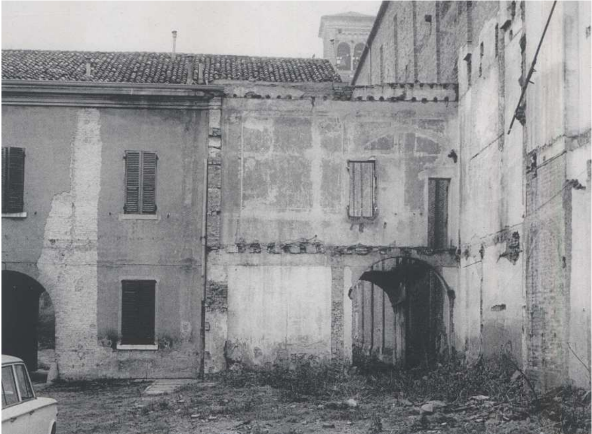
Fig.[1.64] Vista della porzione destra della facciata Ovest dei Chiostri.
