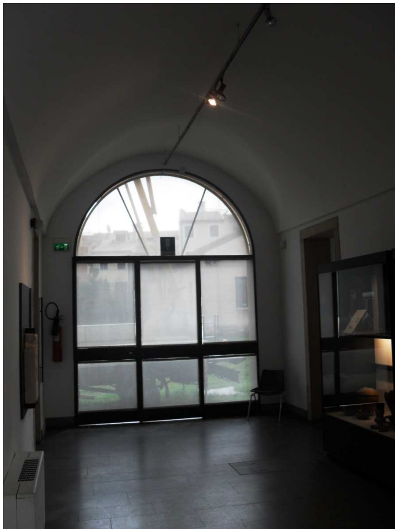
Fig.[2.24] Partizione trasversale del corpo di fabbrica orientale voltata a botte.
