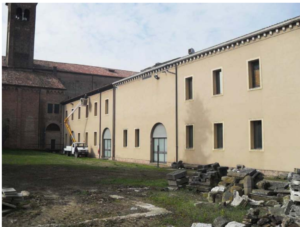
Fig.[2.14] Vista da nord del prospetto Est.
