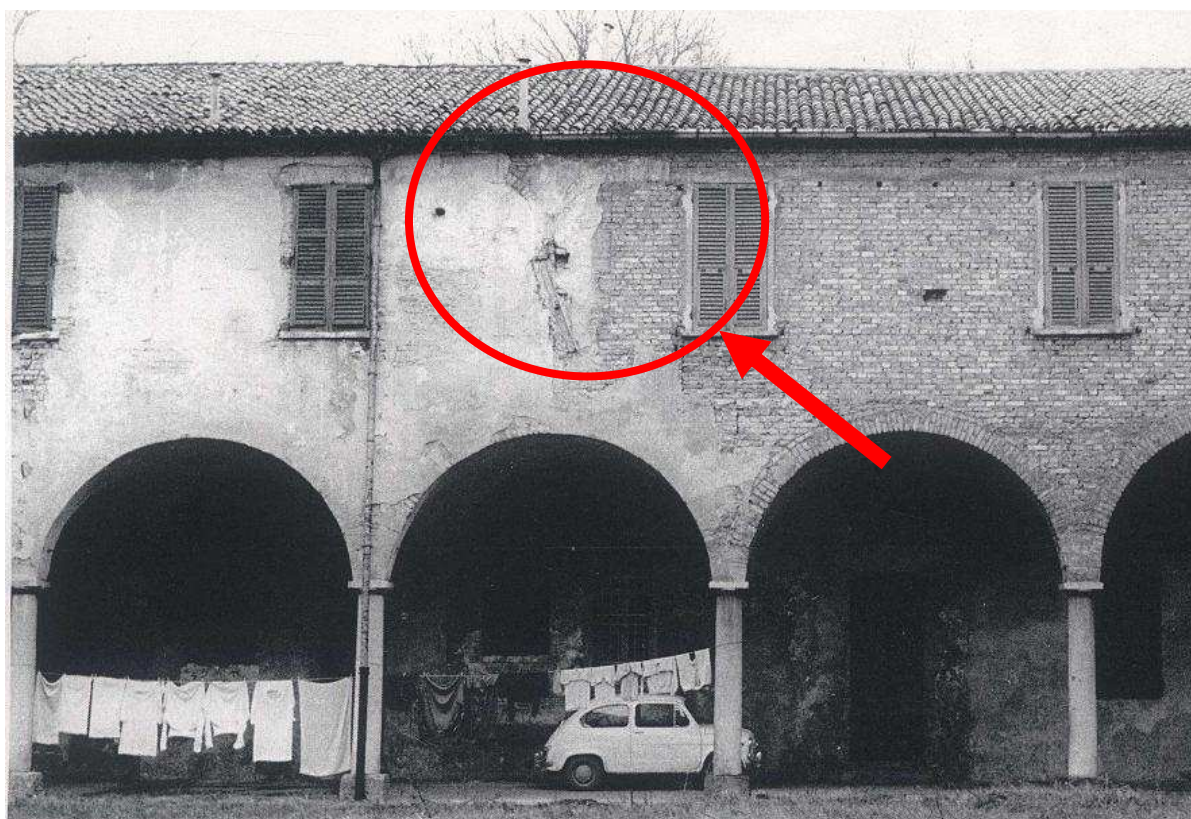
Fig.[5.18] Sotto il paramento murario che componeva il prospetto nord negli anni '60 si può notare la sagoma di un'arco del loggiato originario.
