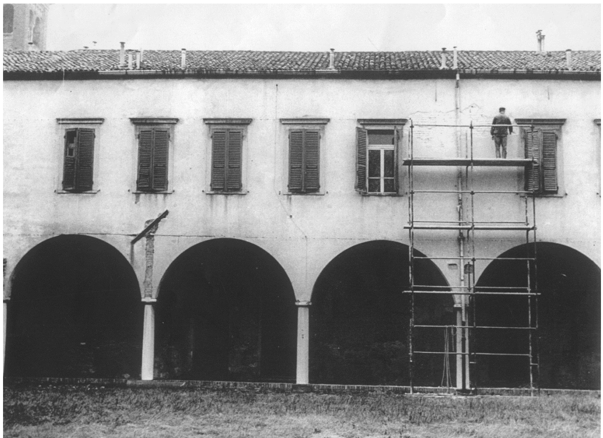
Fig.[1.57] Vista della porzione centrale della facciata Sud del Chiostro Maggiore.
