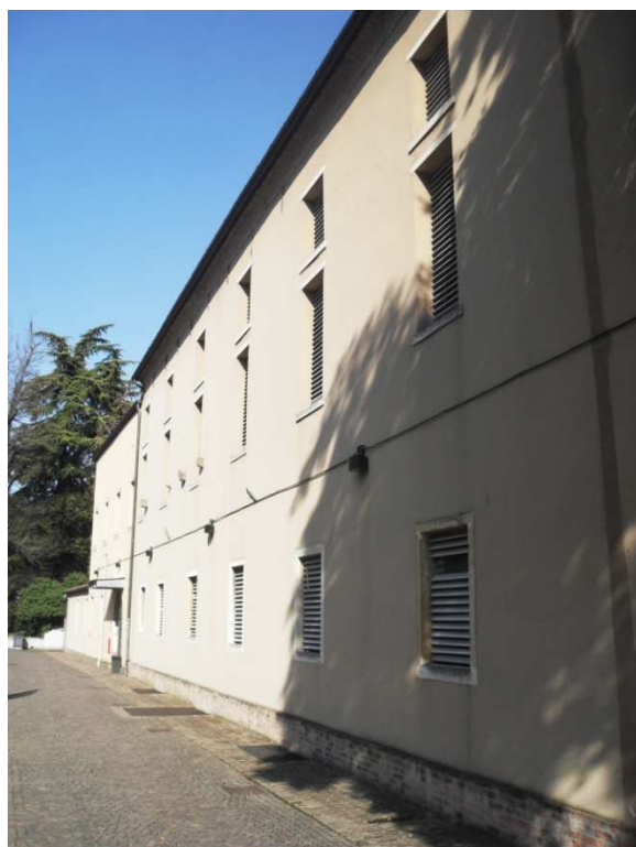
Fig.[2.6] Vista da sud del prospetto Ovest.
