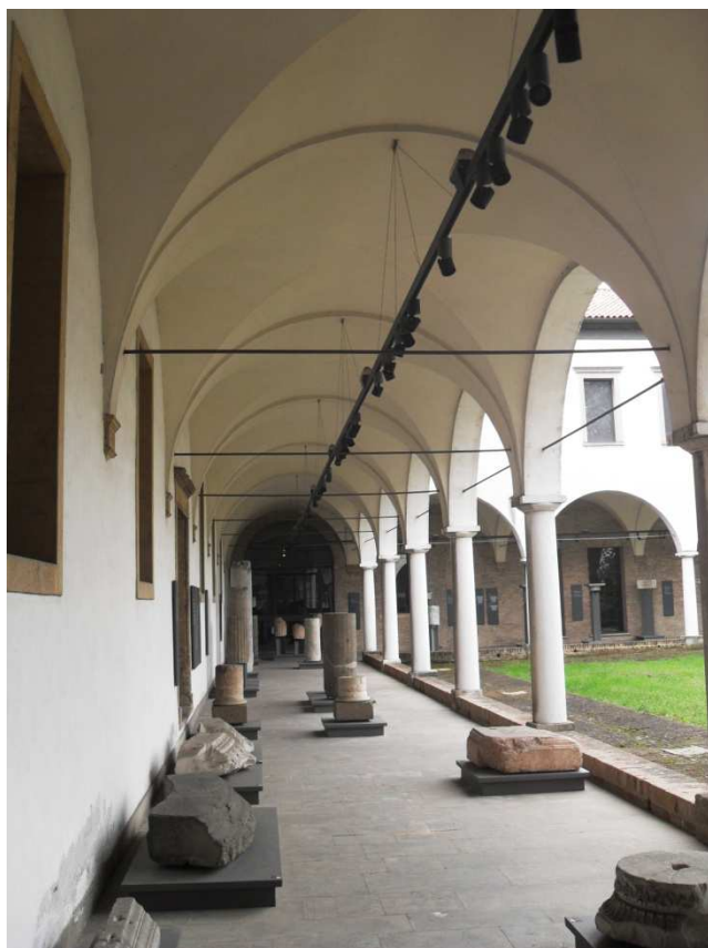
Fig.[2.18] Particolare delle volte a crociera del portico Est.
