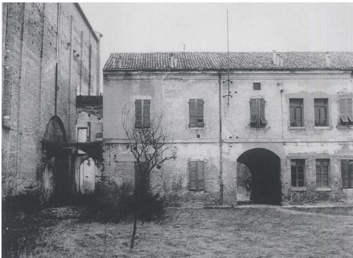
Fig.[1.59] Vista della porzione sinistra della facciata Ovest del Chiostro Minore.
