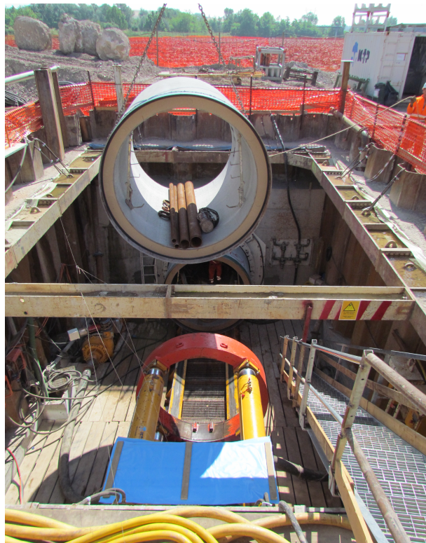
Figura 22 Fase di inserimento del nuovo tratto di condotta al termine della manovra di perforazione
