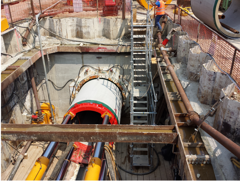
Figura 1Cantiere di Microtunneling.
