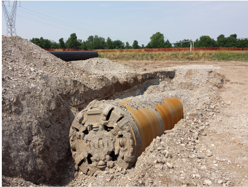
Figura 19 Microtunneler in superficie al termine dei lavori.
