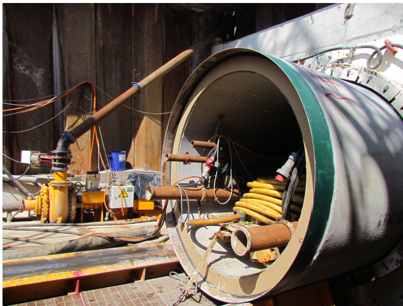
Figura 21 Concio di calcestruzzo posizionato nel pozzo di spinta.
