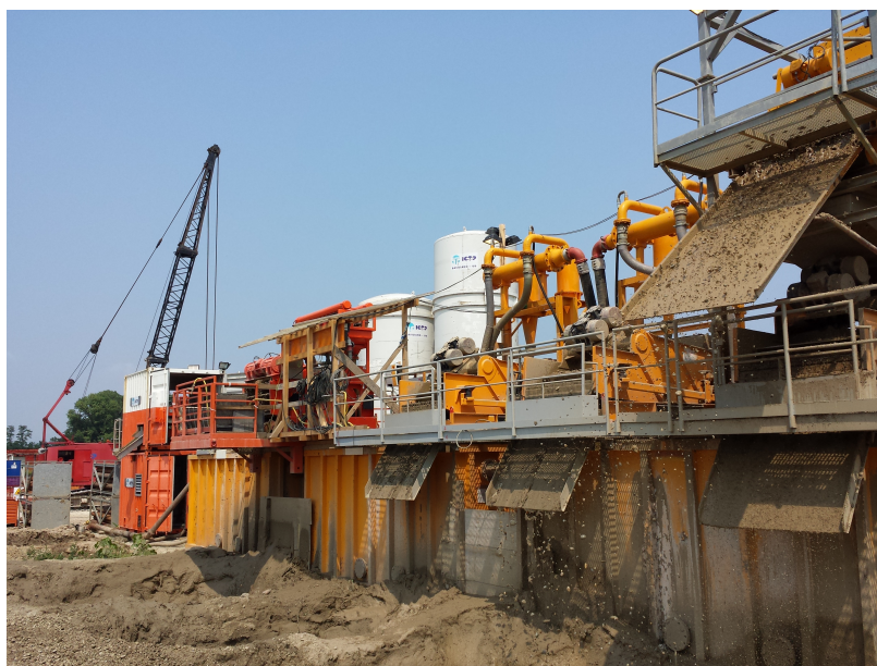
Figura 45 Panoramica del cantiere 2.
