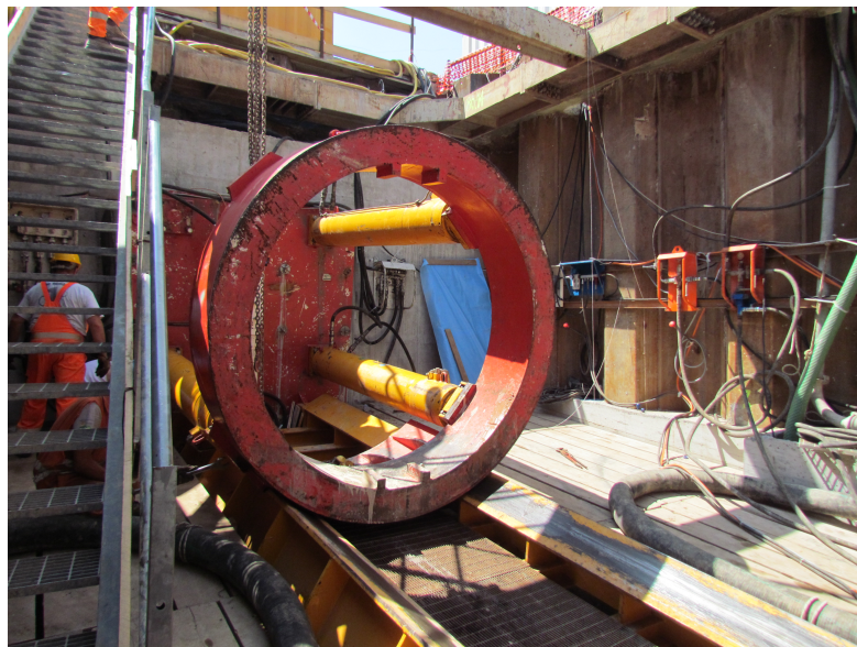
Figura 20 Particolare del pozzo di spinta: muro di contropinta e slitta con martinetti idraulici.
