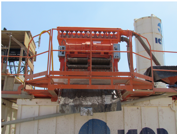
Figura 10 Particolare dell'impianto di separazione: il Desilter.
