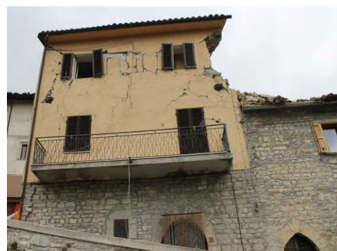
(b) U.S. 109, prospetto sud: e destra si nota il meccanismo fuori piano.
