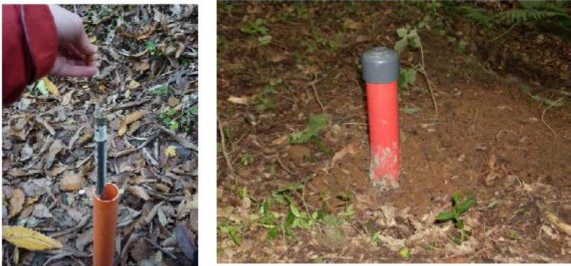
Figura 8 - Sonda capacitiva inserita nel pozzo piezometrico
