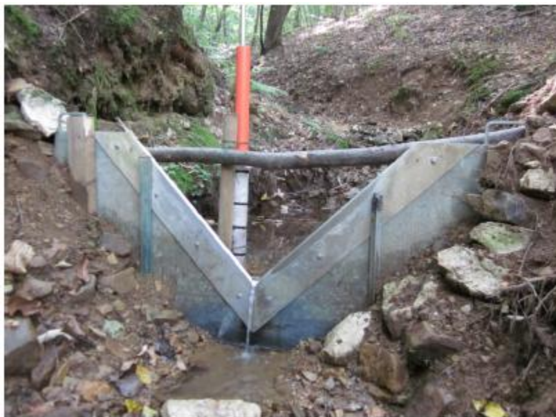
Figura 12 - Stramazzo triangolare installato nel torrente Ressi, con idrometro
