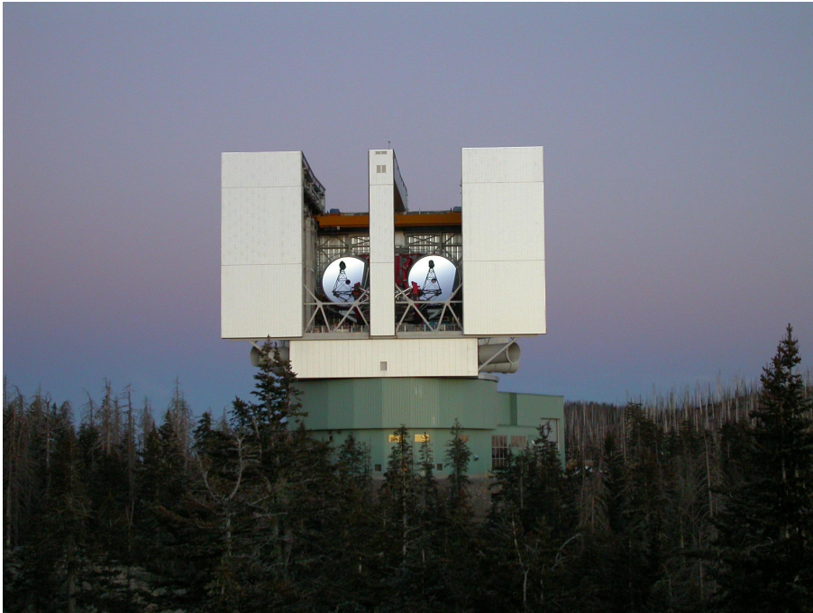
Figura 6.1: Il Large Binocular Telescope. Si possono notare gli spiders, atti a sostenere i secondari o le camere sul primo fuoco, che occultano una porzione dei primari
