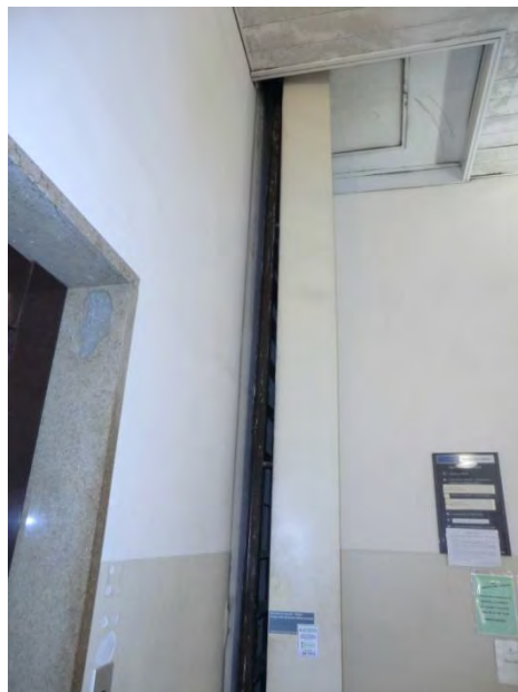
Figura 4.28: Accesso al sottotetto
