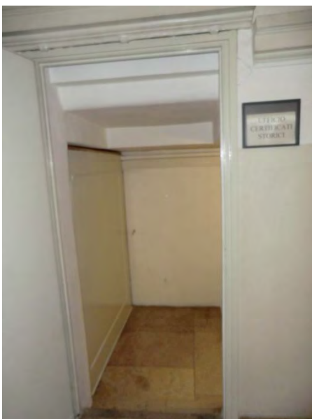
Figura 4.19: Accesso al piano ammezzato
