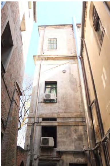
Figura 4.5: Prospetto Sud sul cortile
