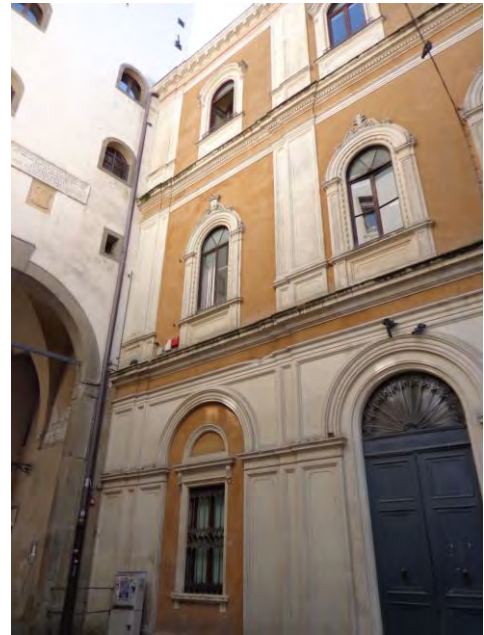
Figura 4.4: Prospetto Nord su Corte del Capitaniato e torre dell'orologio
