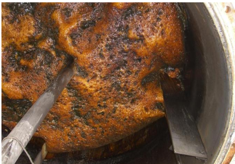
Figura 4.5: interno del reattore dopo l'incidente: si nota la presenza di frangiflutti.
